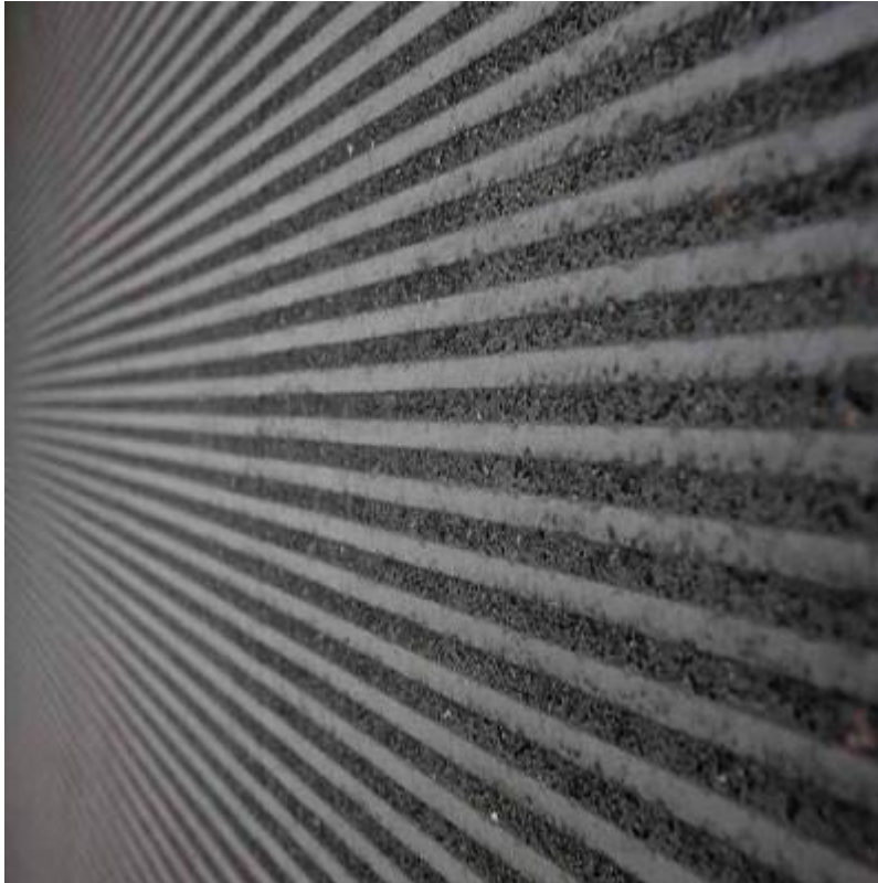
kuva 8. Graafinen betoni julkisivuna [12].
