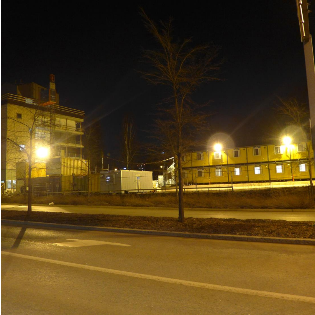
Kuva 6. Kirkkaasti valaistu työmaa-alue Leppävaarassa. (Kuva Johanna Nuotio.)
