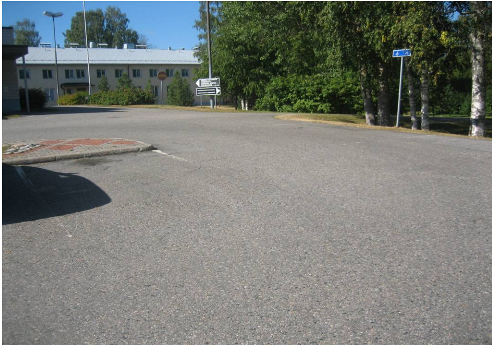
Kuva 29. Liikuntaesteisille tarkoitettut pysäköintipaikat (Kuhmon terveysasema)
