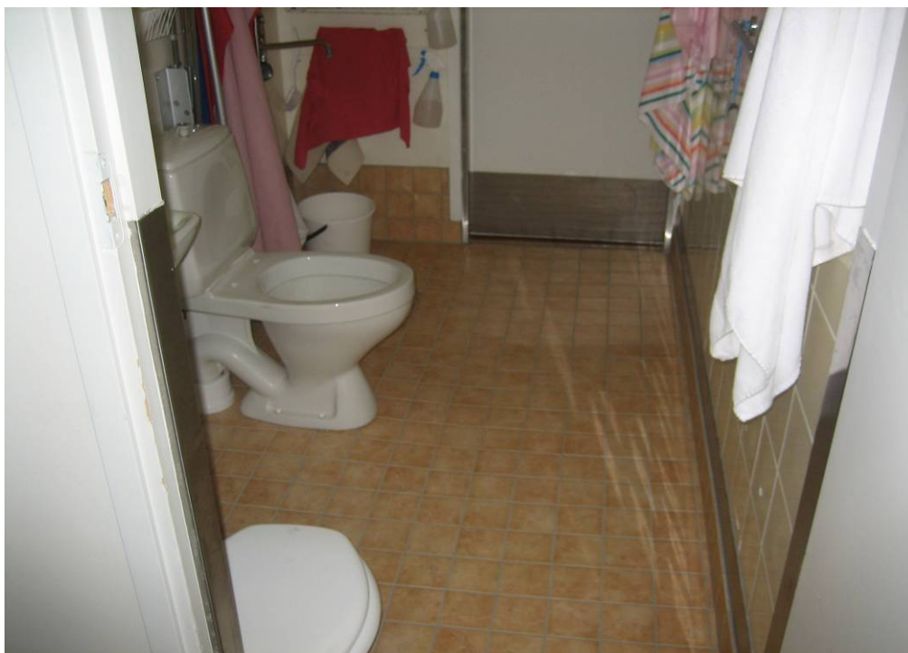
Kuva 34. Ahdas wc-tila (Hoitokoti Kappelikuja)
