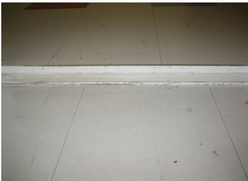
Kuva 38. Palo-osastoivan oven kynnys (Hyrnsalmen terveysasema)
