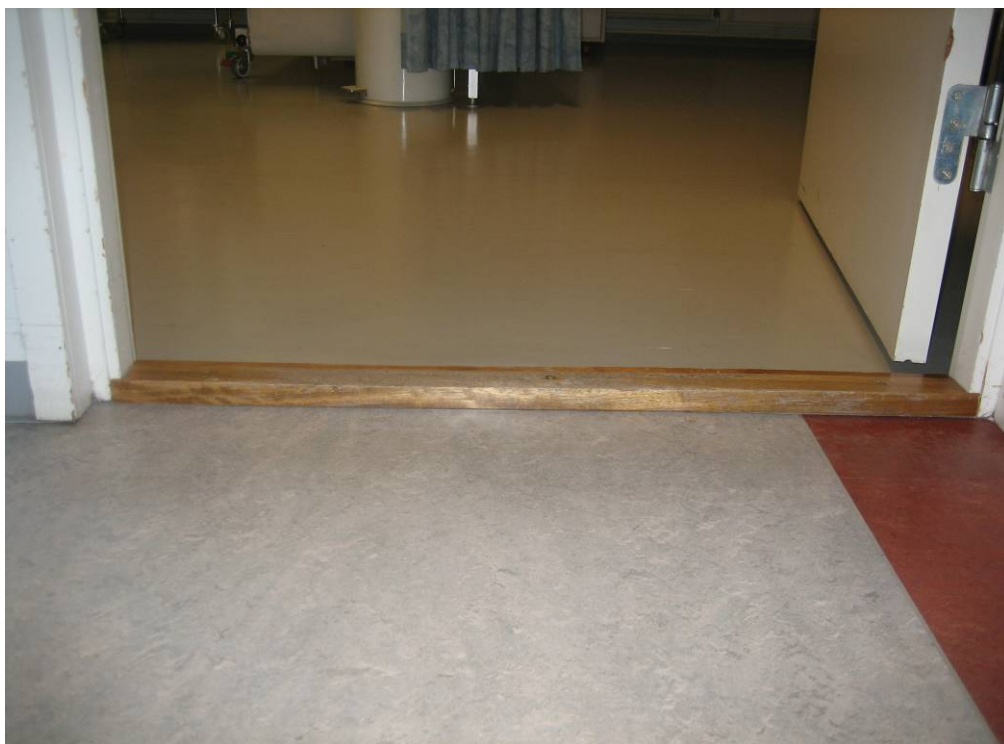
Kuva16. Hoituhuoneen oven kynnyks (Lehtikankaan terveystasema)
