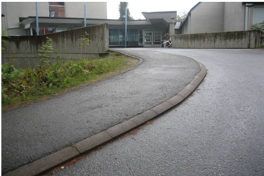
Kuva 1. Kulcutie pääövelle (Kajaanin terveysasema)
