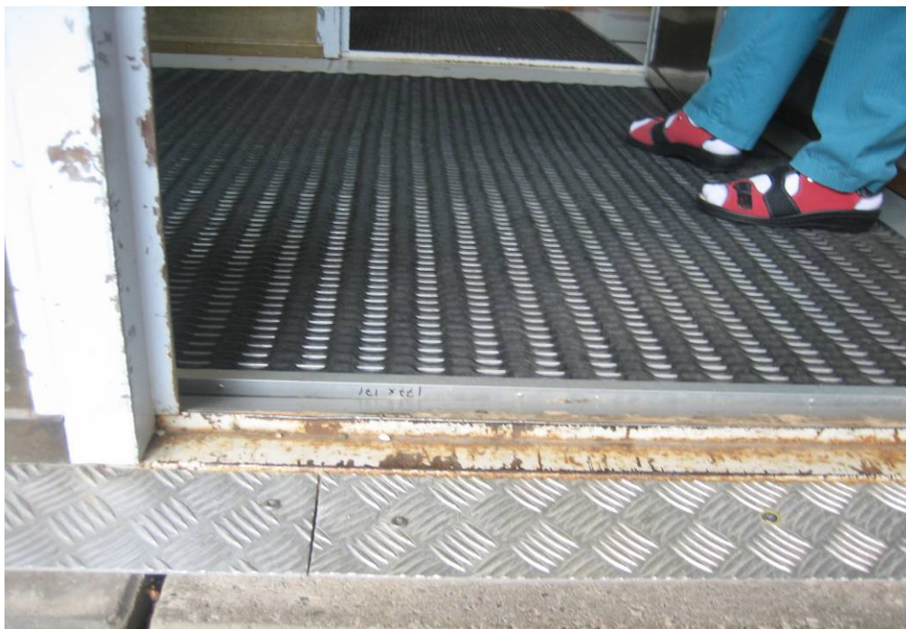
Kuva 37. Ulko-oven kynnys ja eteistilan kumimaton korkeus (Hyrnsalmen terveysasema)
