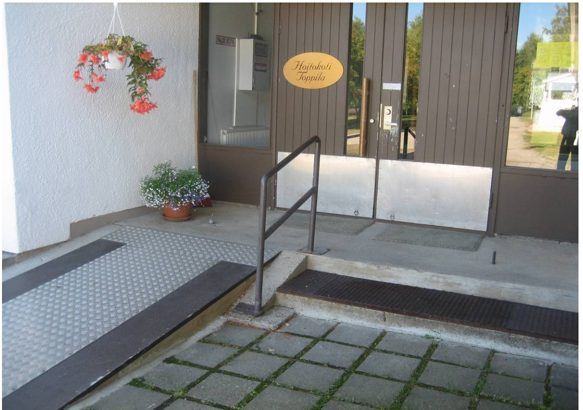
Kuva 8. Hoitokoti Toppilan pääsisäänkäynti
