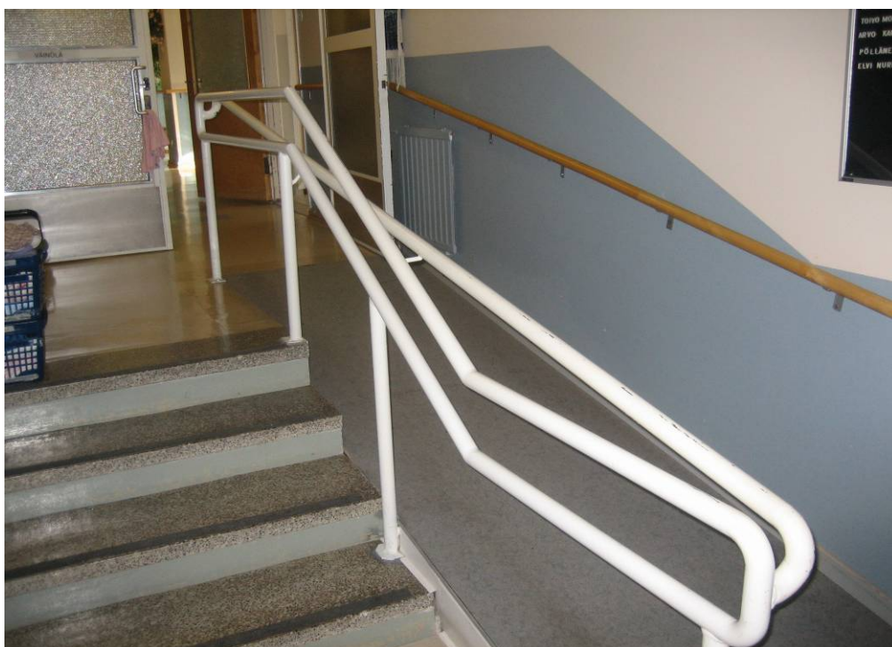
Kuva 44. Käytävätilasta osastolle menevä kulkuluiska (Hoitokoti Kurimo)
