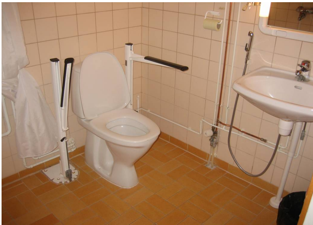
Kuva 47. Liikunta- ja toimintaesteisten wc (Hoitokoti Koivuranta)
