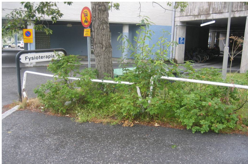
Kuva 3. Opastus liikuntaesteisten autopaikoille (Kajaanin terveysasema)
