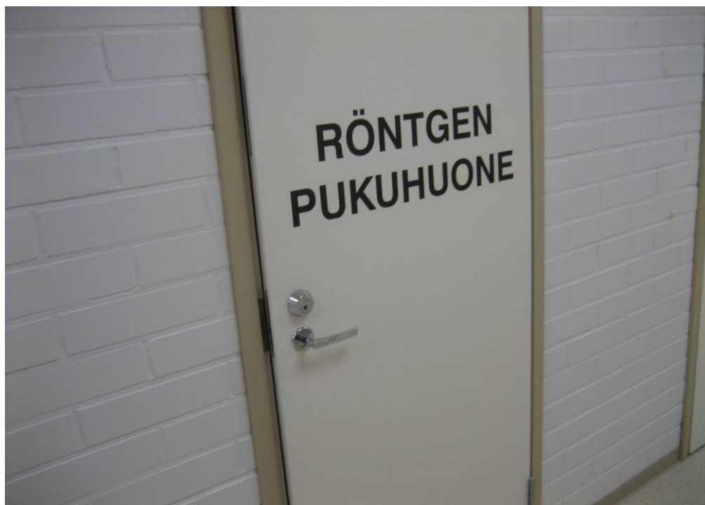
Kuva 49. Röntgenin pukuhuoneen ovi (Paltamon terveysasema)
