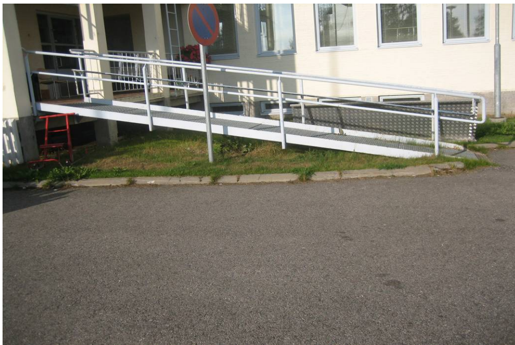
Kuva 41. Liikunta- ja toimintaesteisten sisäänkäyntiluiska (Hoitokoti Kurimo)
