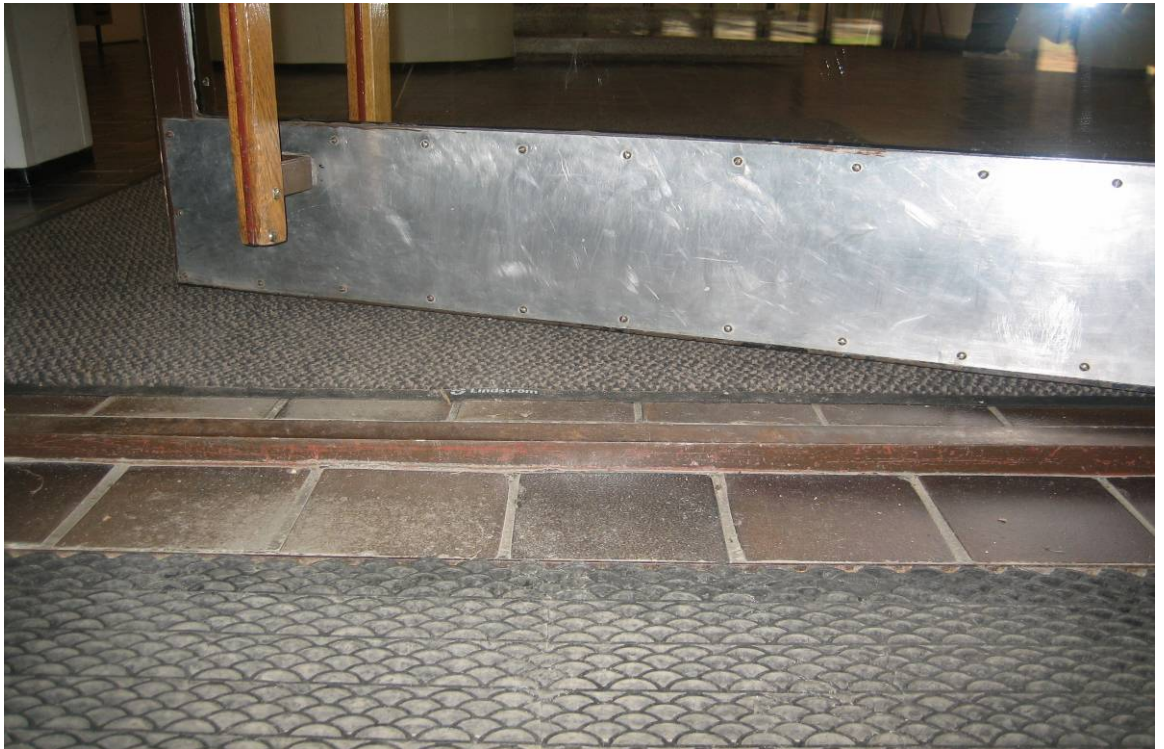
Kuva 10. Pääsisäänkäynnin oven korkea kynnyks
