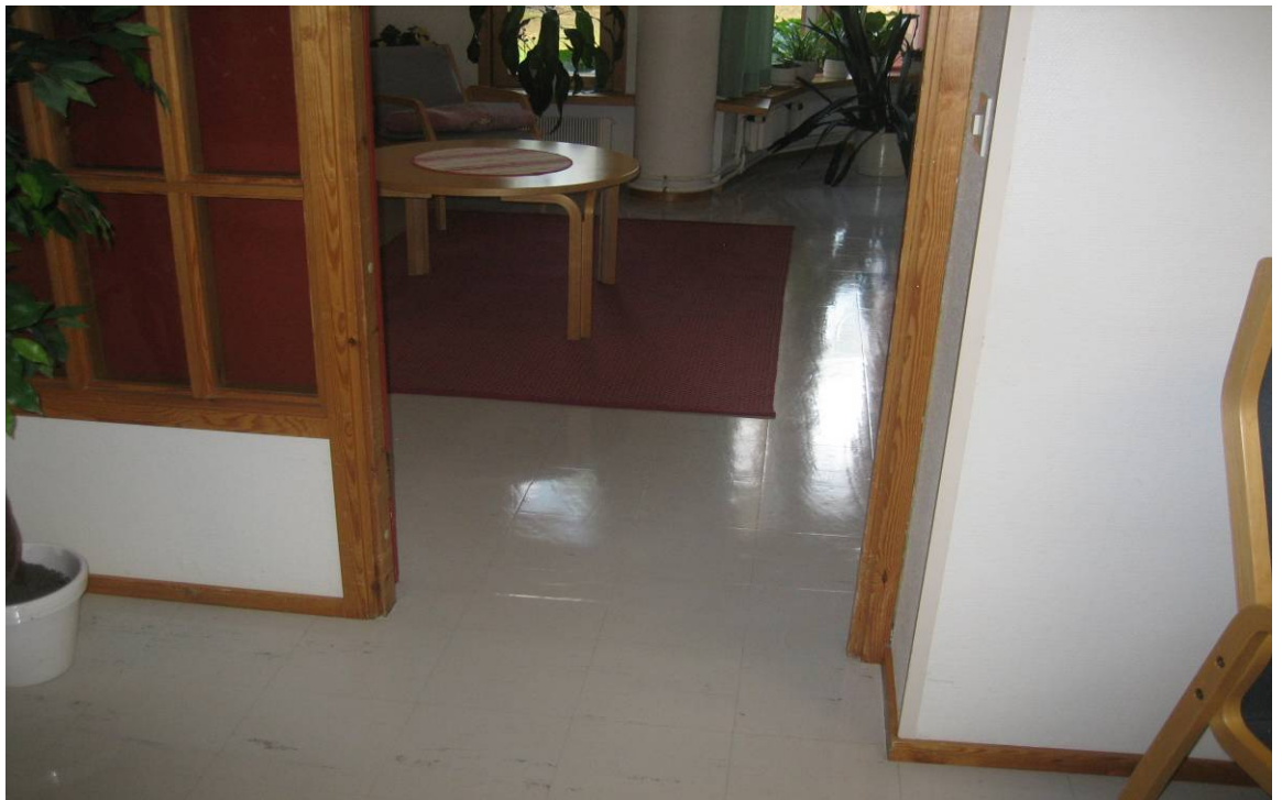
Kuva 20. Päivähuoneeseen johtava oviaukko
