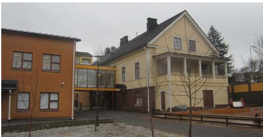
KUVA 14. Vanhan puolen julkisivu ja yhdyskäytävä (Kuva: Suvi Virta 2016)
