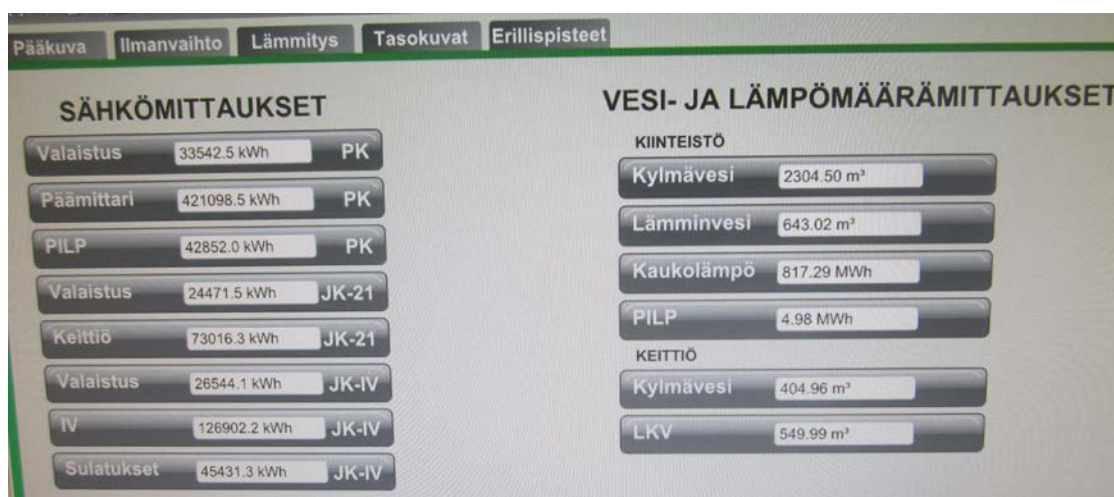
KUVA 39. Valvomokuva kiinteistön energian- ja vedenkulutusmittauksista (Kuva: Suvi Virta 2016)
