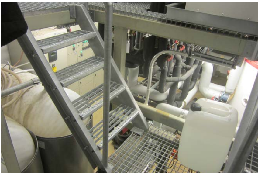
KUVA 8. Lämmönjakuhuoneen kahden kerroksen väliset portaat (Kuva: Suvi Virta 2016)
