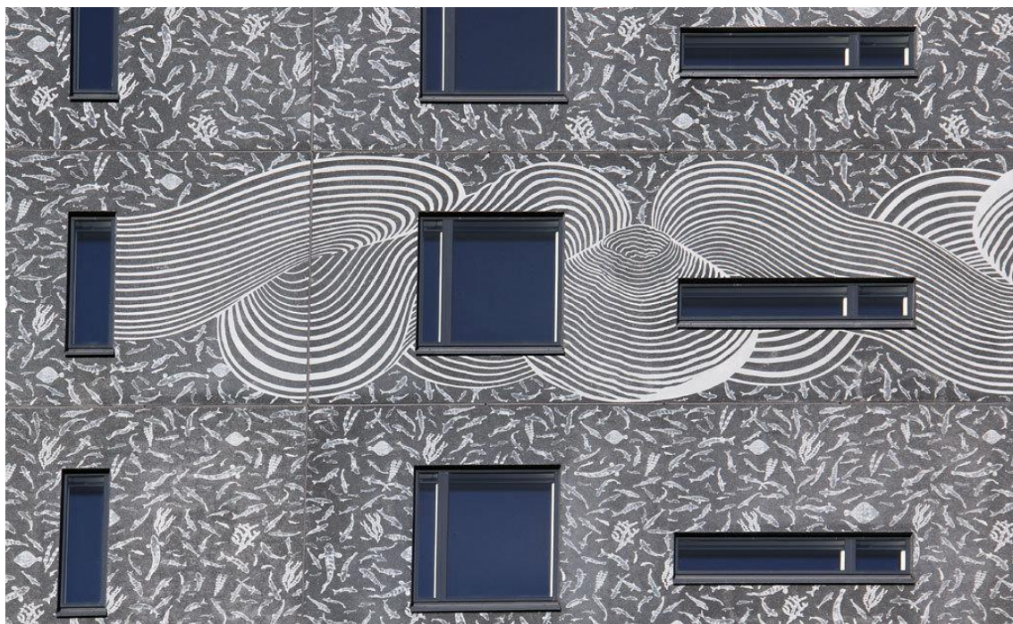
Kuva 9. Meriaiheinen julkisivu graafisella betonilla [22].
