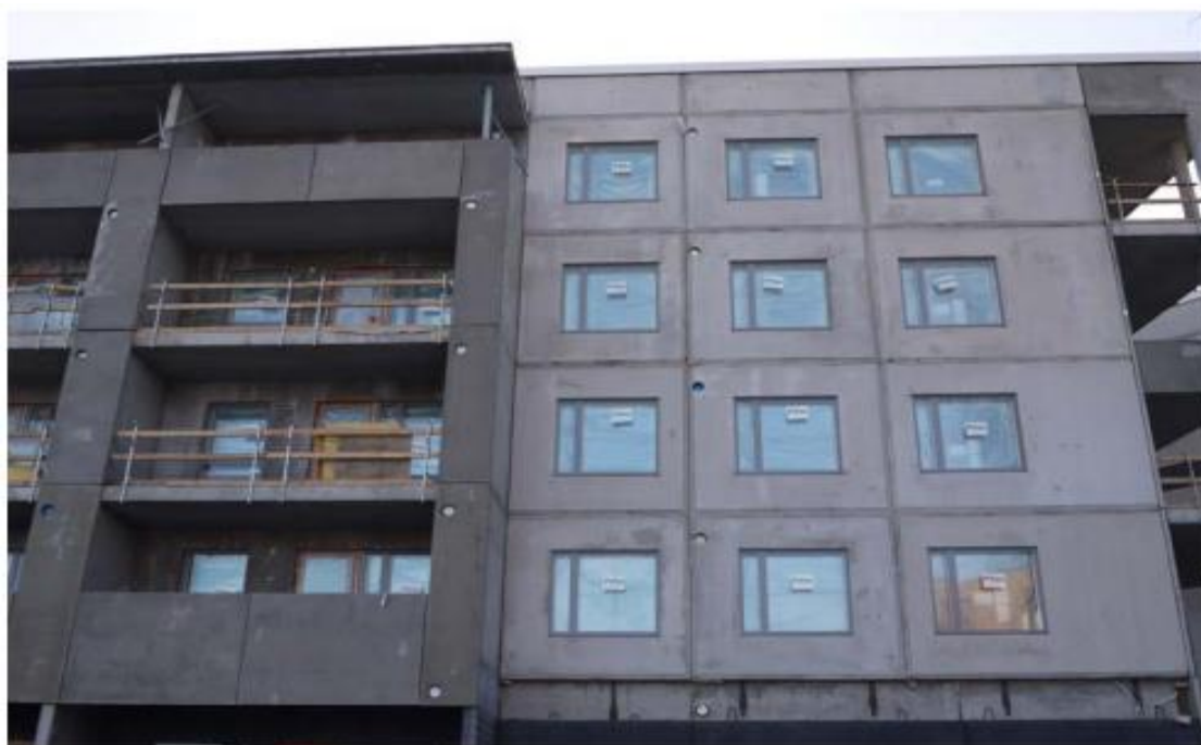
Kuva 16. Julkisivu kohteessa 3, ennen pintarappausta
