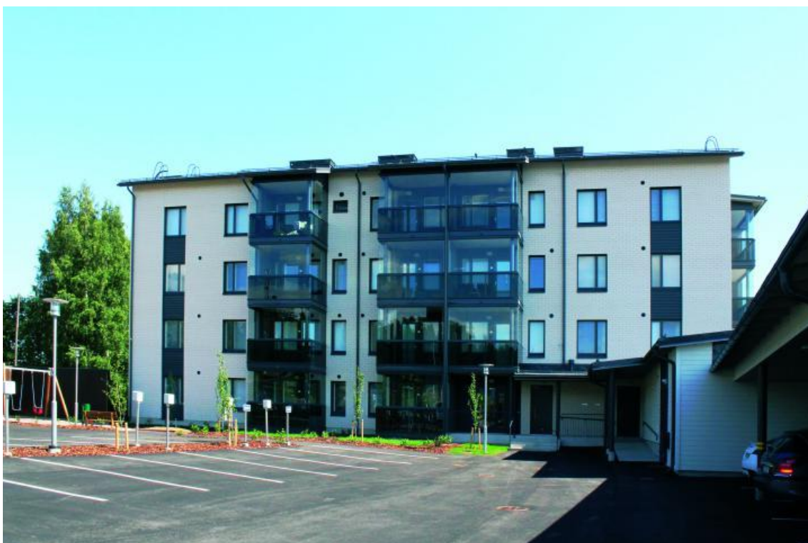
Kuva 11. Kohteen 1, pihan puoleinen julkisivu
