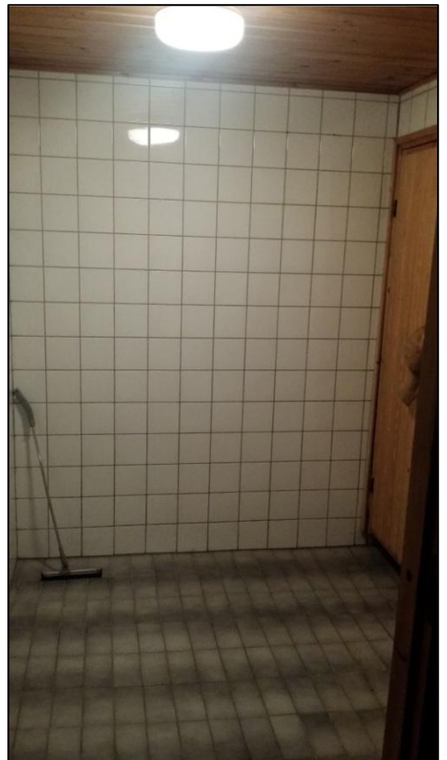
KUVA 9 Näkymä D suihkutilaan (Korhonen 2016.)
