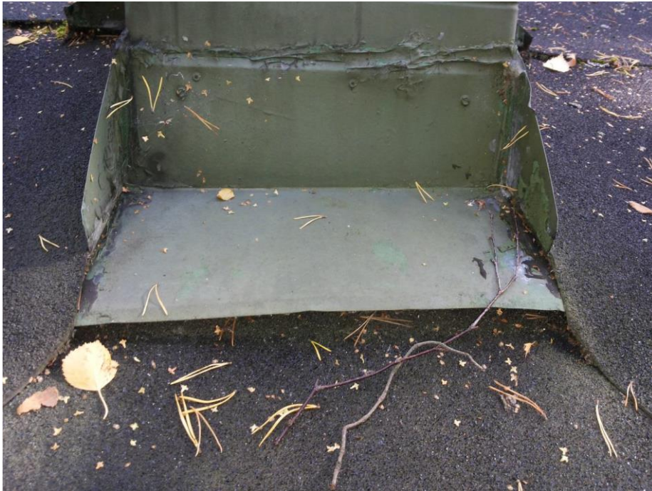
Kuvio 6. Hirren painumisesta johtuva piipunpellityksen irtoaminen alustastaan (kuva Marko Sarkkinen).
