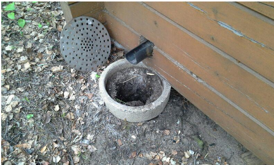
Kuvio 2. Hirsisaunan pesuvesien maahanimeytyskaivo (kuva Jukka Malinen).
