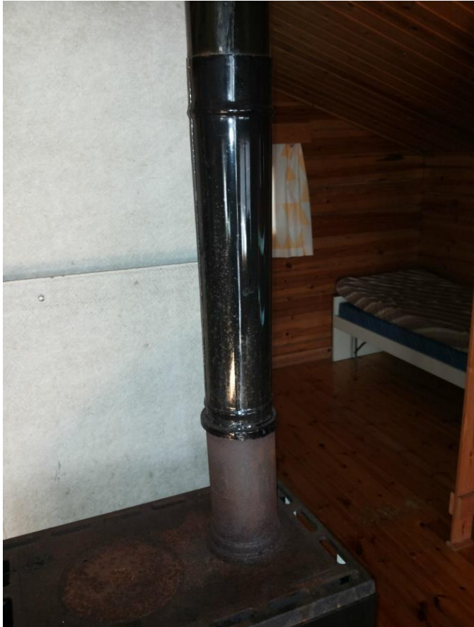
Kuvio 8. Piipun muhviosan ylemmän jatko-osan virheellinen limitys (kuva Marko Sarkkinen).
