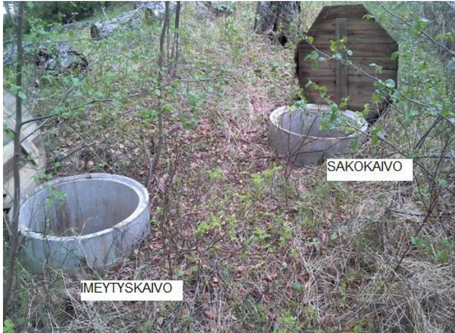
Kuvio 1. Ärjänsaaren kahvion sako- ja imeytyskaivo (kuva Jukka Malinen).
