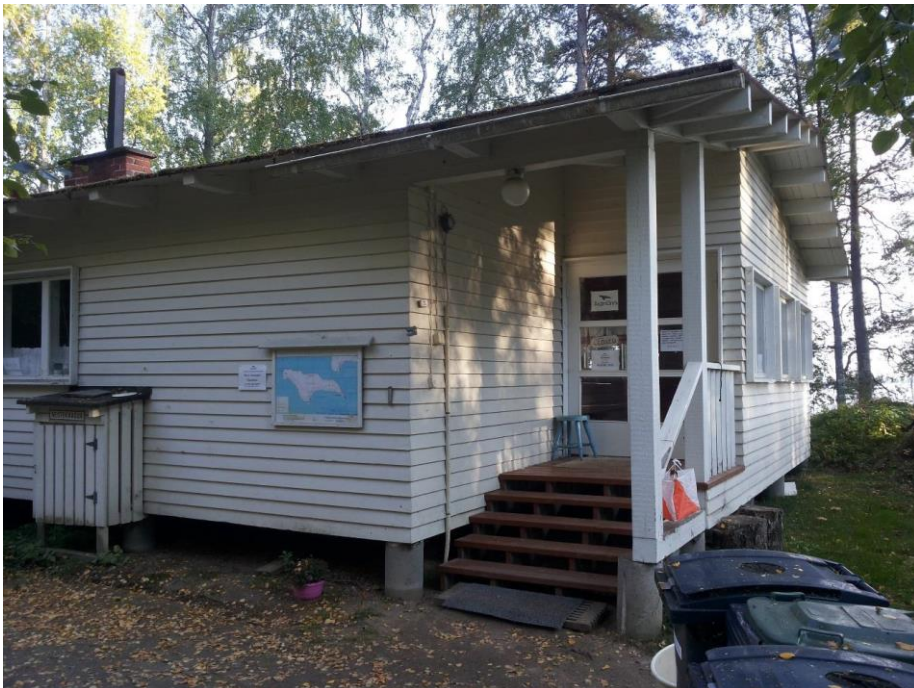
Kuvio 3. Vuonna 1958 valmistunut huoltorakennus, jota on valmistumisen jälkeen laajennettu useampaan kertaan (kuva Marko Sarkkinen).
