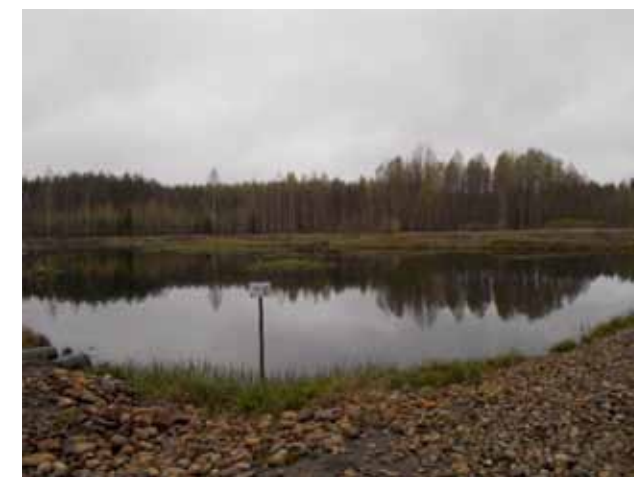
Kuva 16. Näkymä Ruukkisuon kosteikolle 19.05.2015.
