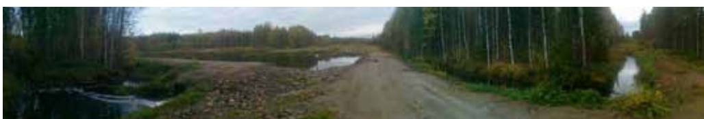
Kuva 7. Ruukkisuon kosteikko 27.09.2013. Kosteikolle tuleva vesi kiertyy kuvan oikeassa reunassa olevaa ojaa myöten kosteikkoon. Vesi poistuu kuohuen kosteikosta kahta rumpuputkea myöten, kuvassa vasemmalla.
