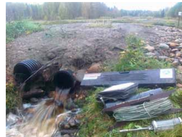
Kuva 8. Ruukkisuon lähtevän veden rumpuputket sekä tutkimuskalustoa 27.09.2013. Virtaama oli tuolloin 56,5 l/s.
