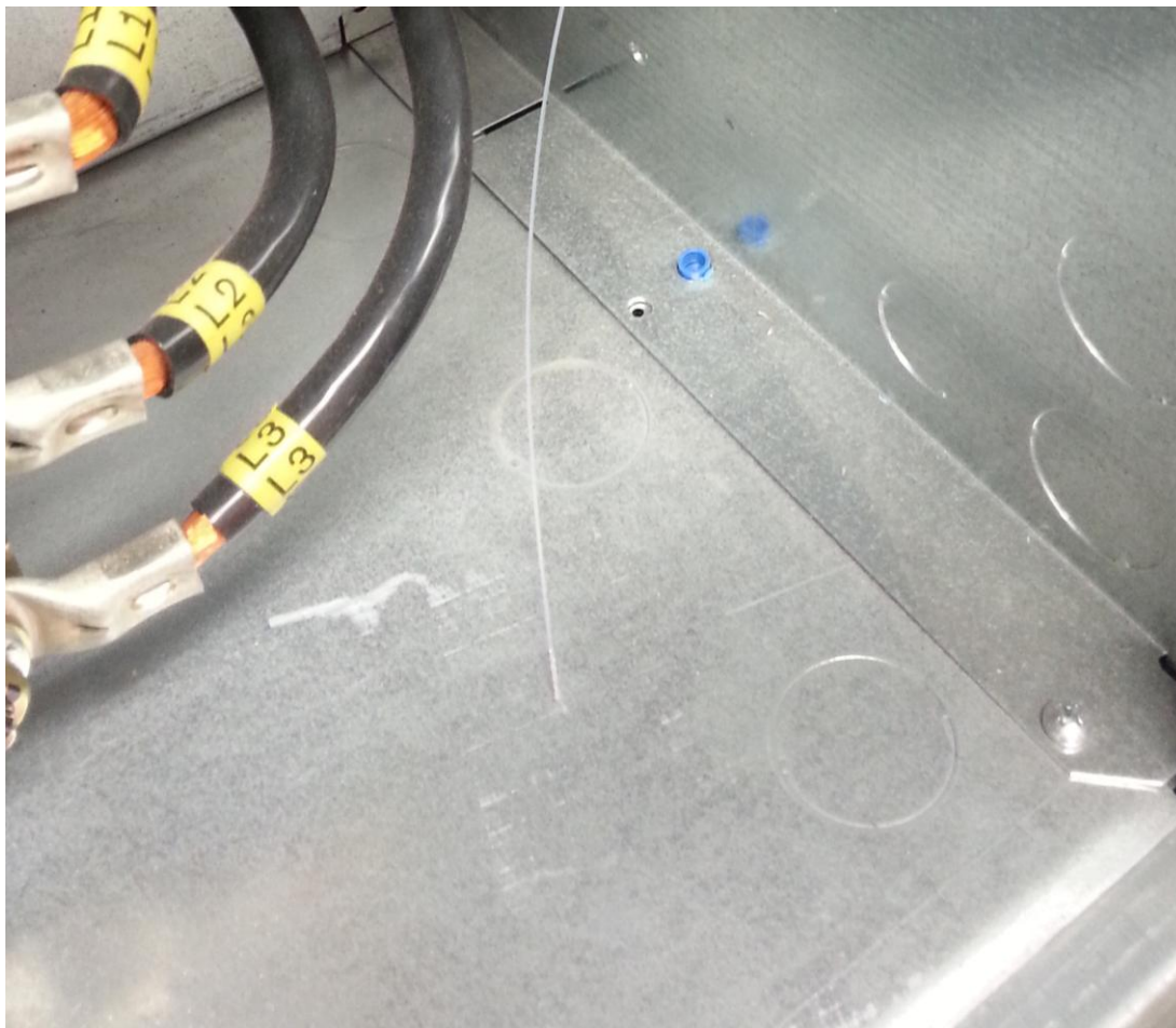
Kuva 4. Katkennut havaitsinkuitu.
