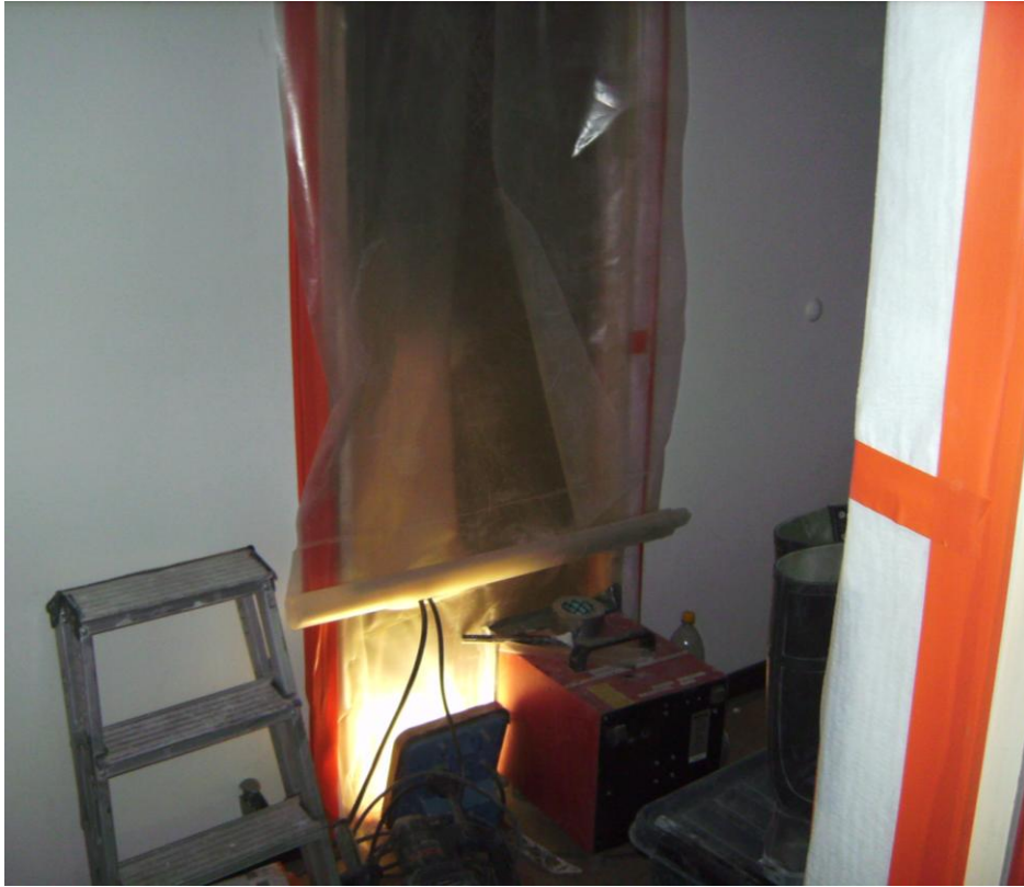
KUVA 13. Kylpyhuoneen purkutyössä käytetty pölynhallintaovi ja alipaineistaja
