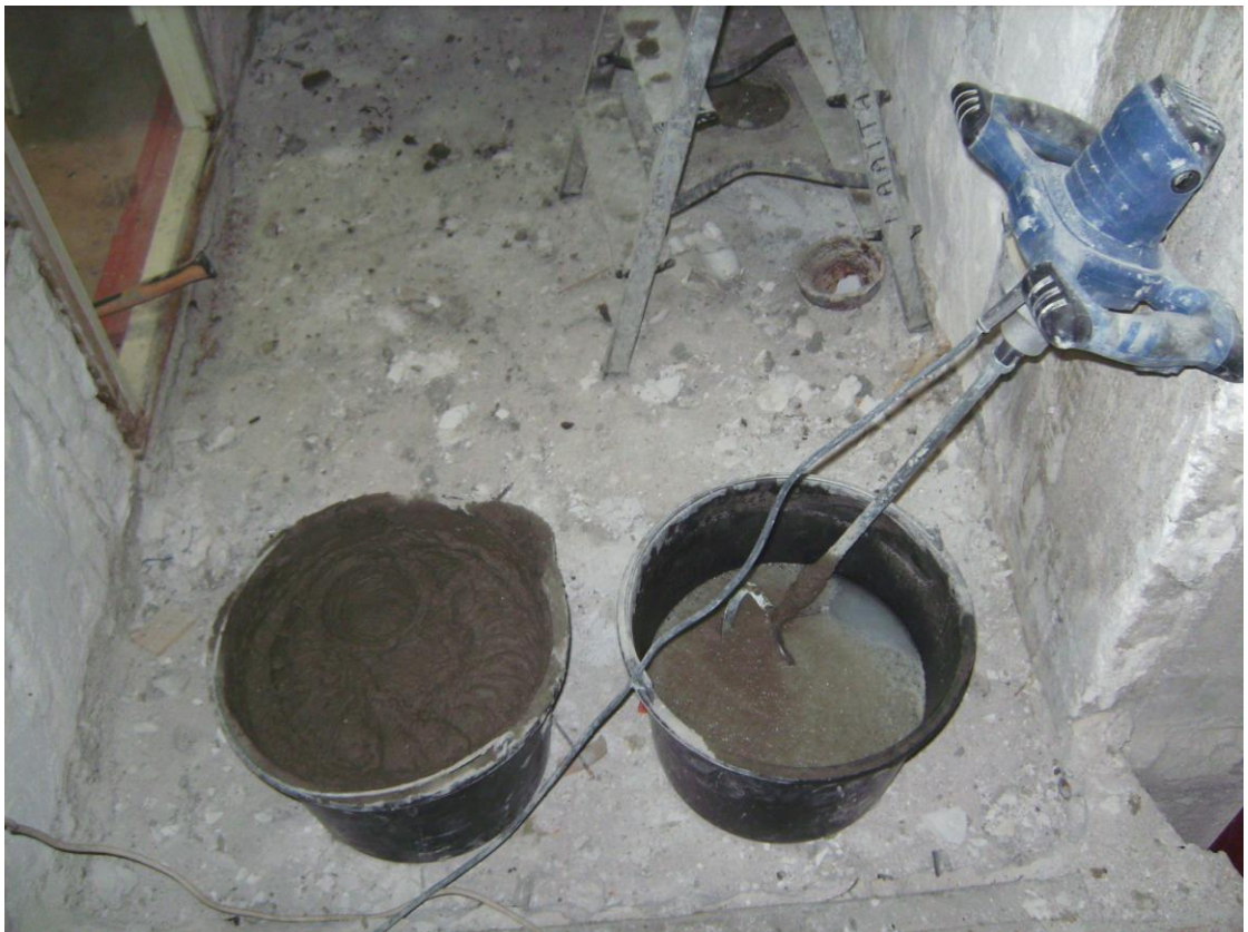
KUVA 18. Tasoitteen sekoitus kylpyhuoneessa
