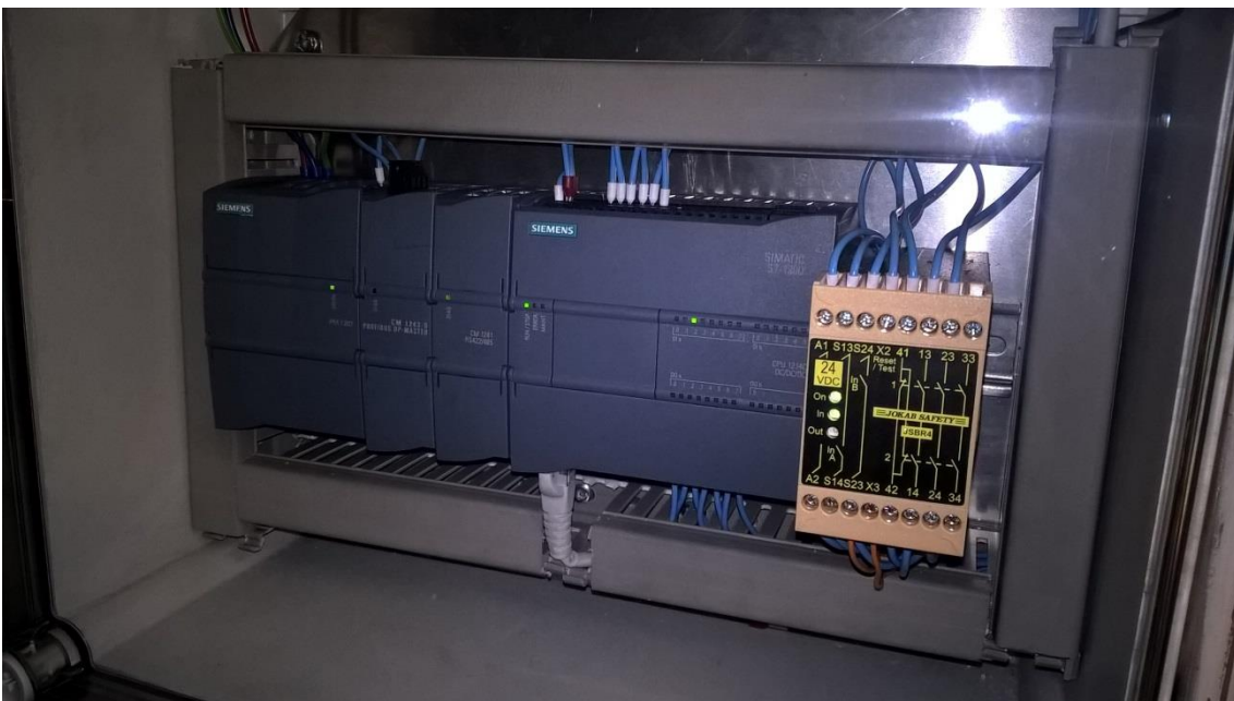
KUVA 3. Turvarele ei ole vetäneessä tilassa
