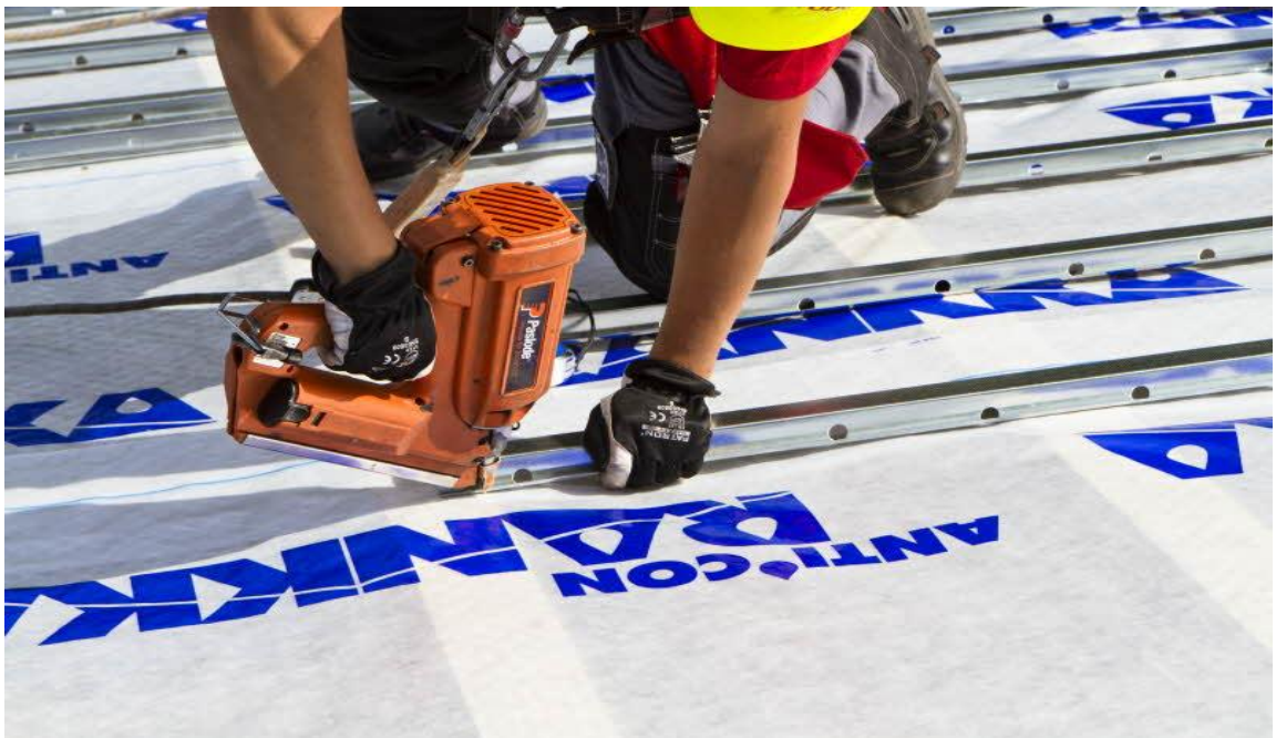
Kuvio 13. Tuulettavan teräsruoteen kiinnitys impulssinaulaimella (Ruukki Construction Oy 2014).
