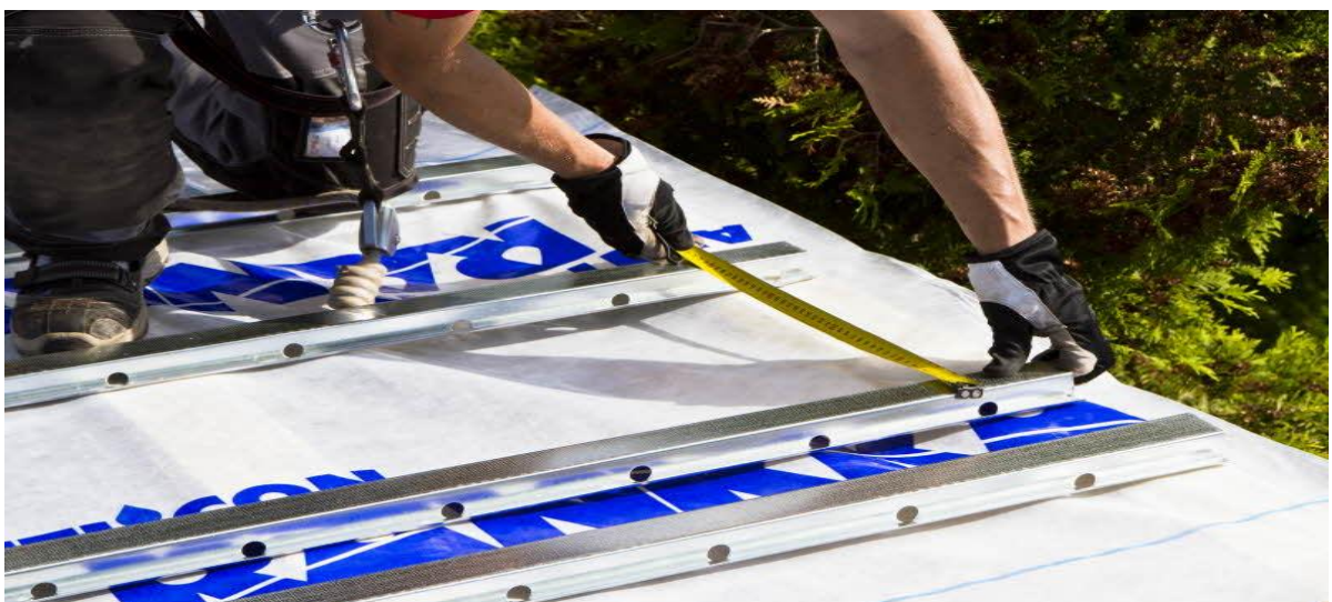
Kuvio 10. Tuulettavan teräsruoteen ruodejaon mittaus (Ruukki Construction Oy 2014).
