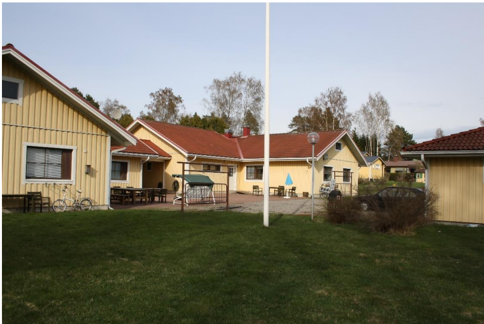
Bild 1 Österby Servicehems bostadshus. Runt omkring har de rikligt med gräsmatta samt prydnadsbuskar.
