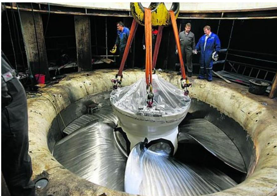
KUVA 6. Merikosken voimalaitoksen uuden juoksupyörän asennus (Sarviaho, 2008)
