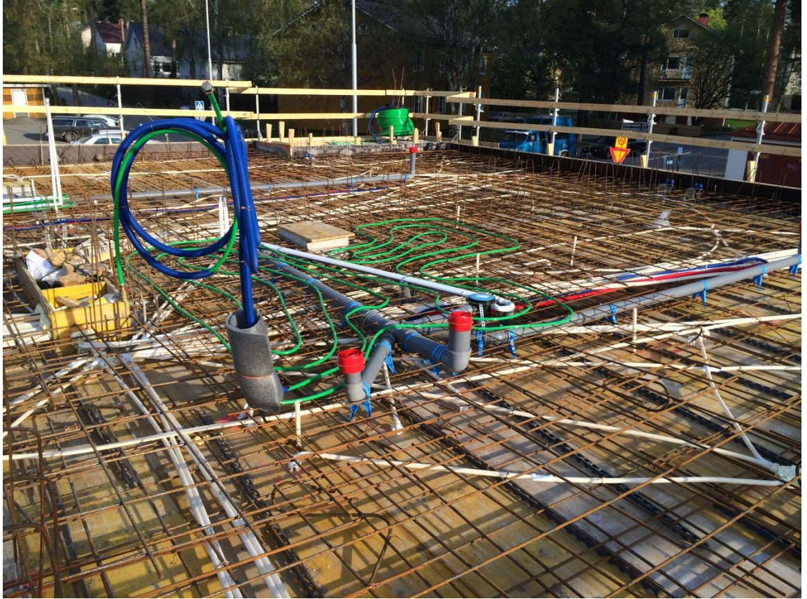
Kuva 4. Raudoitusverkoilla ja esivalmistetuilla osilla tehty holviraudoitus (Vaaramo 2014)
