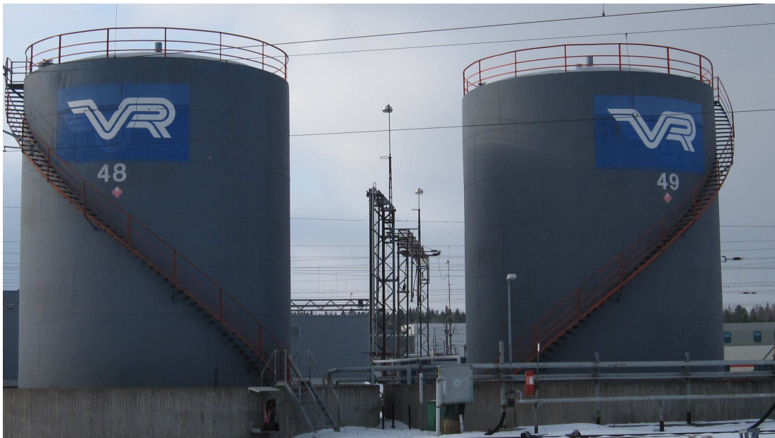
Kuva 4. Ratapihan 2*1000 m 3 polttoöljysäiliöt.
