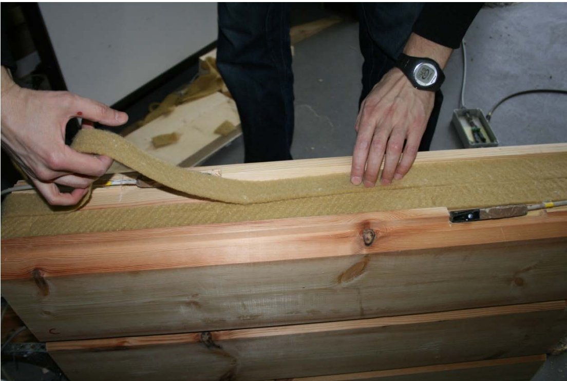
KUVA 2. Polypropeeniriveen asennusta. Valokuva Eemeli Lehmusoksa 2011.
