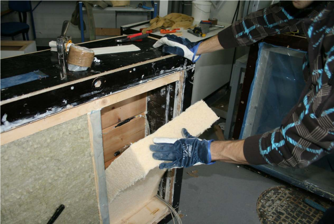
KUVA 6. Eristeiden asennusta kehykseen. Vuorossa Ekovillalevy. Valokuva Eemeli Lehmuksoksa 2011.
