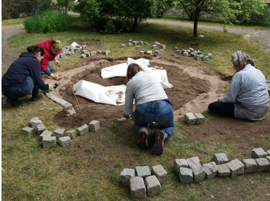
Kuva 21. Kiveyksen asentamista. (Kalliola, 2018)
