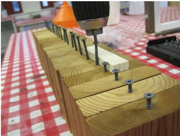
Kuva 2 Ruuvien asennus akkuporakoneella
