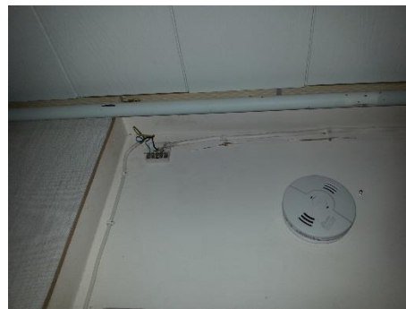
Kuva 23. Vanhat pinnat jätetty uusien alle
