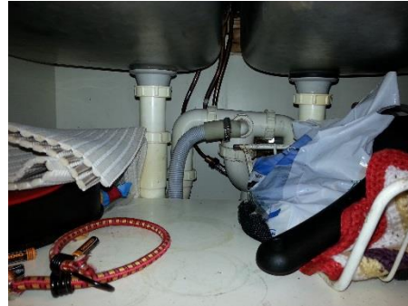
Kuva 27. vesi- ja viemäriputket hyvät.
