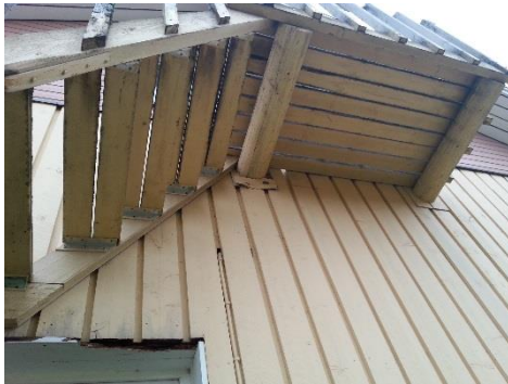
Kuva 7. Yläpohjaan vievät portaat
