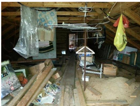
Kuva 9. Yläpohjan ylimääräistä ainesta ja purueriste
