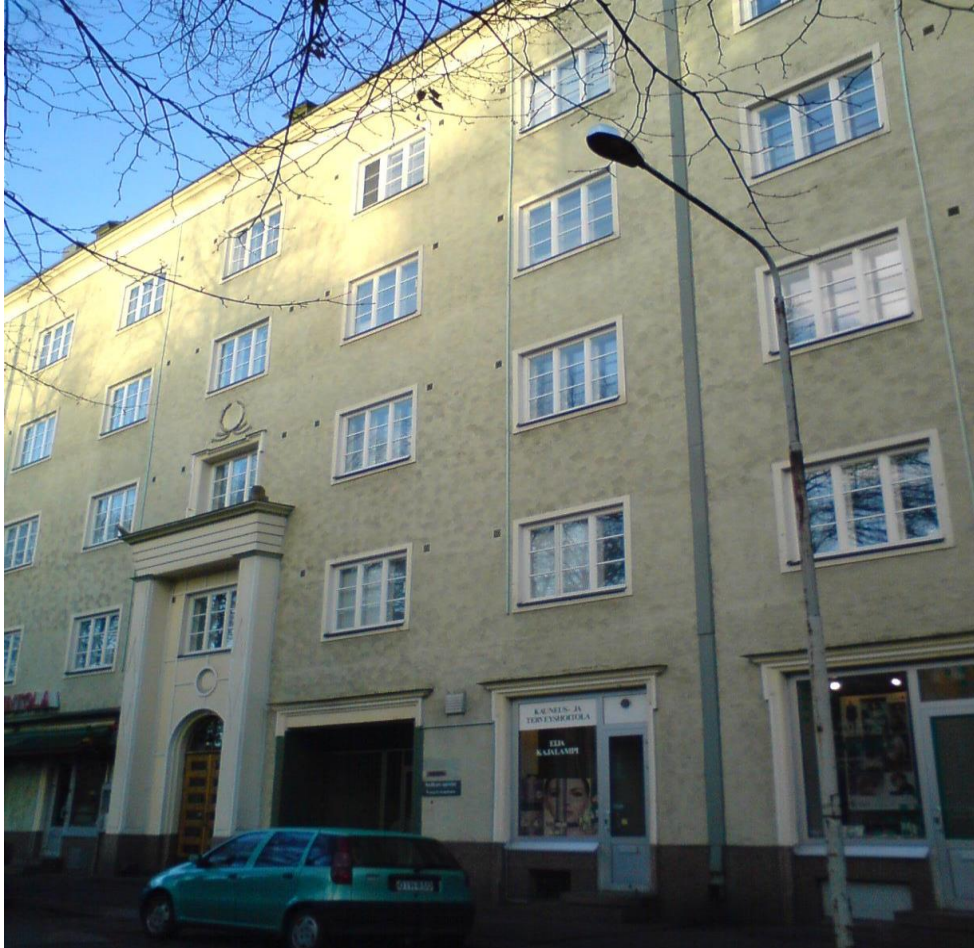
Kuva 2. 1920-luvun kerrostalon julkisivu (Paajanen 2012.)
