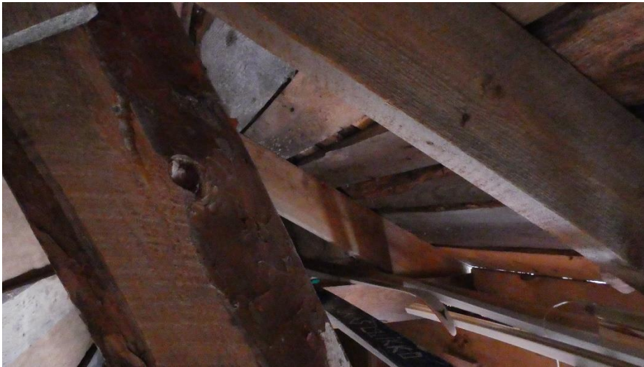
KUVA 9. Kattoristikot näkyvillä yläkerran käyttöullakoilla.
