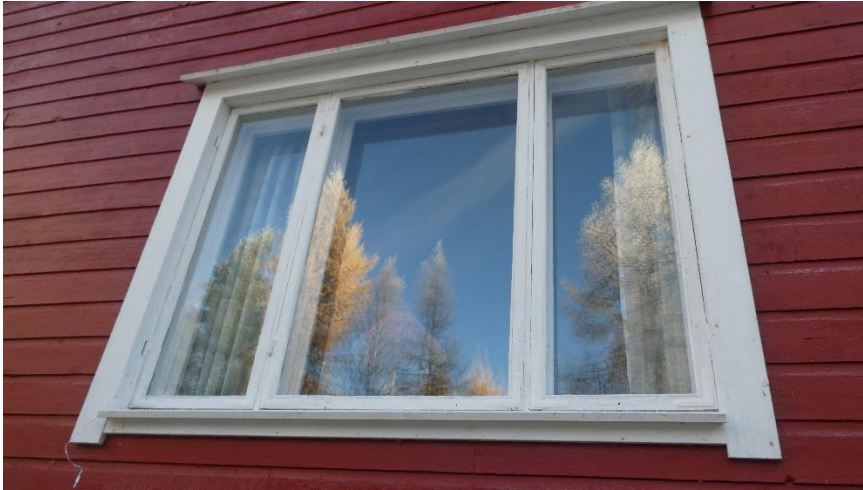
KUVA 7. Nykyiset ikkunat ovat alkuperäiset. Tämä ikkuna on ainut kolmiruutuinen ikkuna, muuta ovat kaksiruutuisia.
