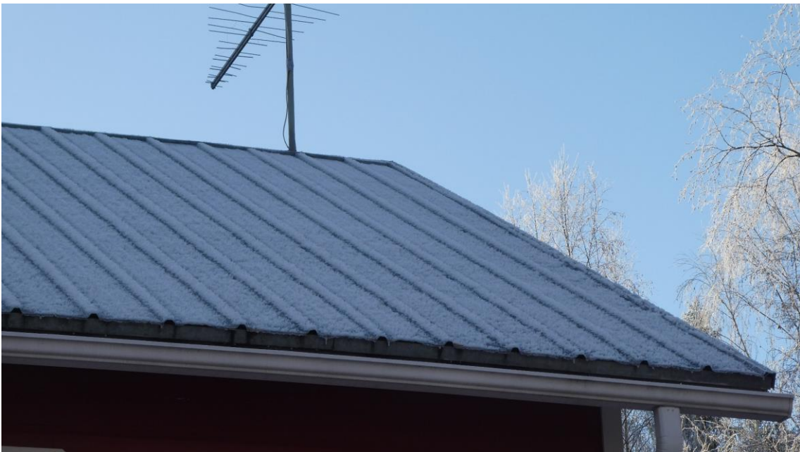
KUVA 11. Sinkitty profiilipeltikate ja muovipinnoitettu vesikouru syöksyineen. Ajalle tyypillinen antenni katon harjalla.
