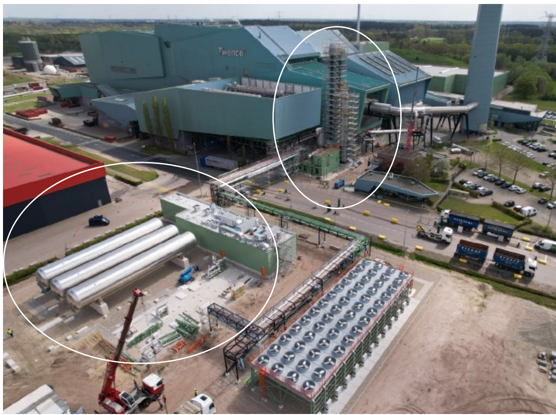
Kuva 4. Twencen ja Akerin yhteistyöhanke Hollannissa. Etualalla hiilidioksidin nesteytysasema sekä kolme säiliötä nesteytettylle hiilidioksidille. Talteenottolaitos Just Catch 100™ osittain rakennustelineillä verhoiltuna. (Aker Carbon Capture 2024)
