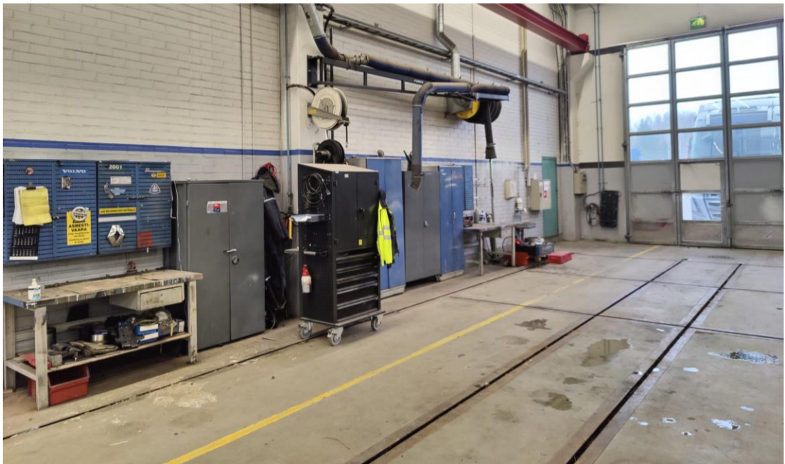
KUVA 27. huoltopaikka 19 siivouksen jälkeen.
