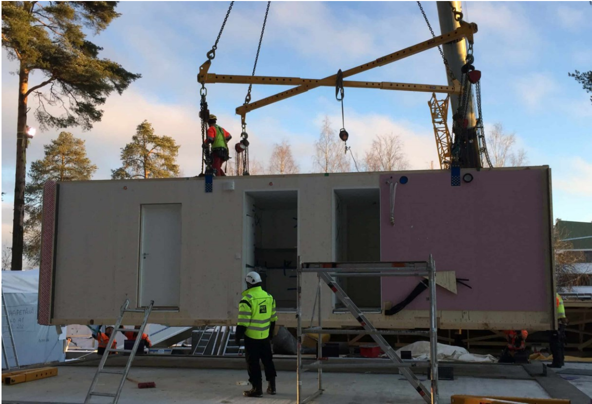
Kuva 11. Ruuvattavilla nosto-osilla suoritettu tilaelementtinosto (Puuinfo B, 2020)
