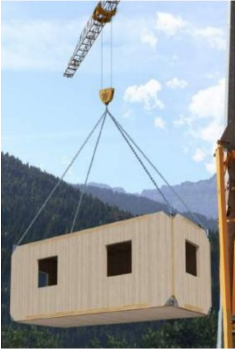
Kuva 13. Tilaelementin nosto X-RAD osalla. (Rothoblaas, 2023)
