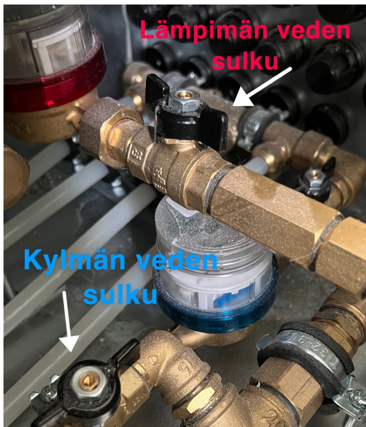
Kuva 1. Asuntokohtaiset vesimittarit ja sulut löytyvät asunnon eteisen liukuovikaapiston pohjasta luukusta.
