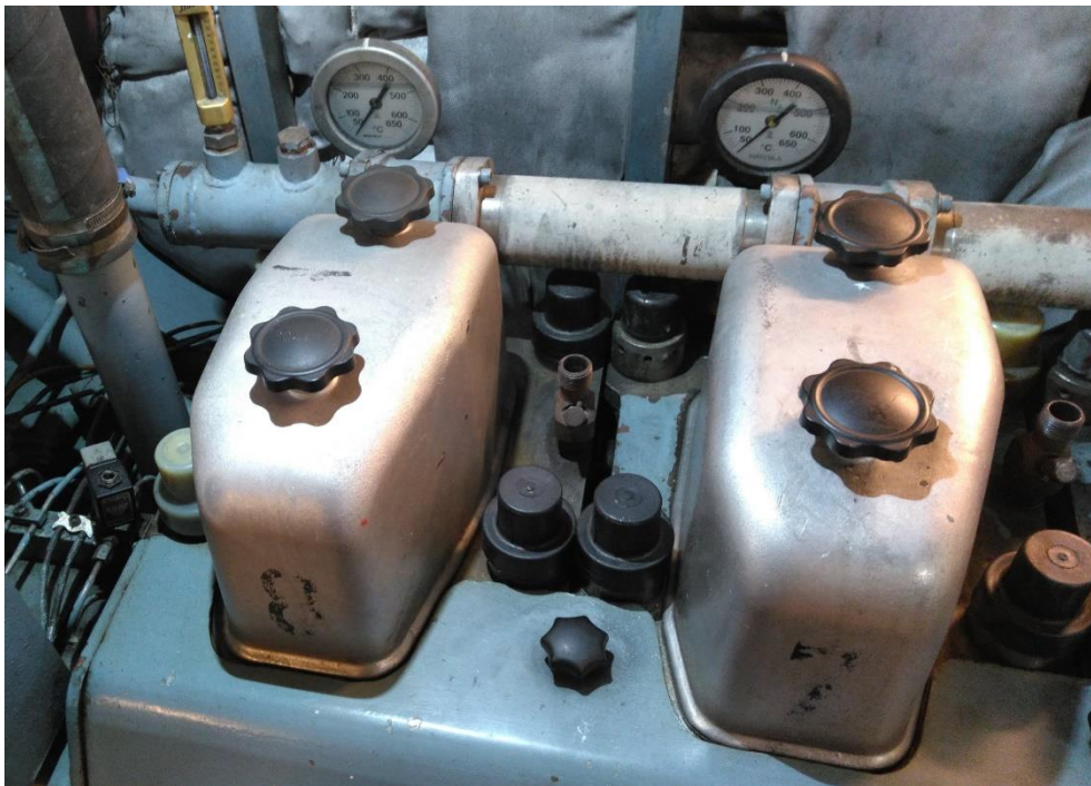
Kuva 6. Venttiilikopat kuvattuina älylaseilla (Akseli Rantanen)
