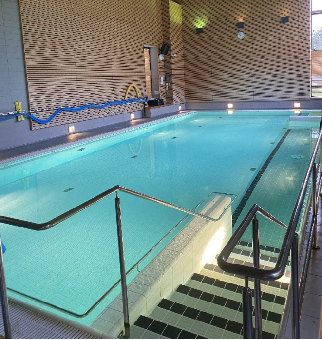
Kuva 4. Hyvinvointikeskus Onnin uima-allas, vedenpinnan korkeus 1,3–1,5 metriä
