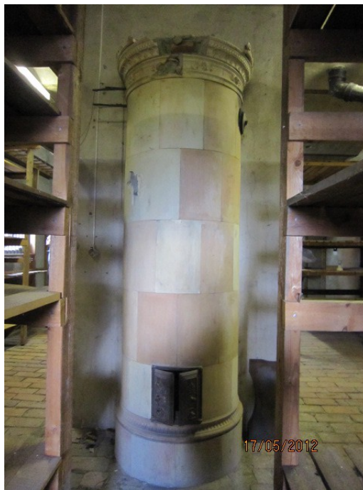
Kuva 3: Näsinlinnan ullakolla oleva lasittamaton uuni
