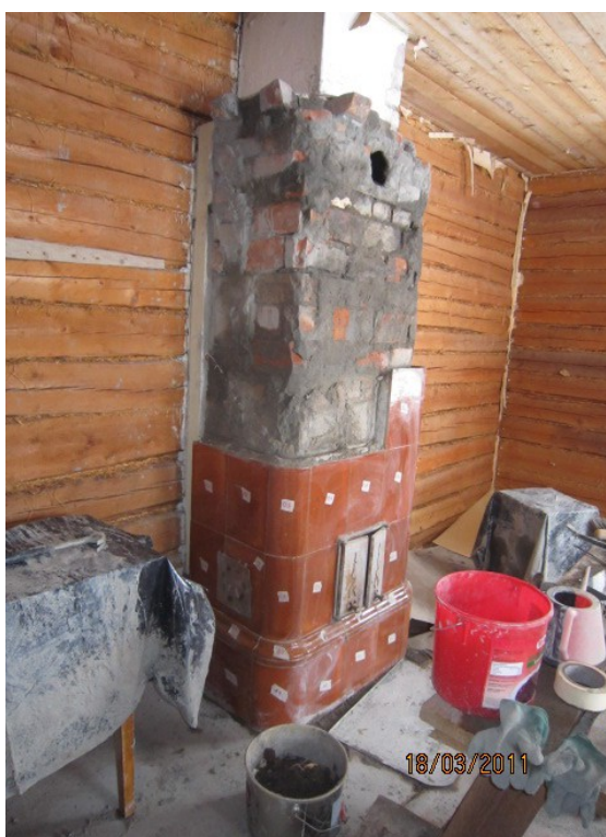
Kuva 1: Kaakeliuuni on muurattu savilaastilla
