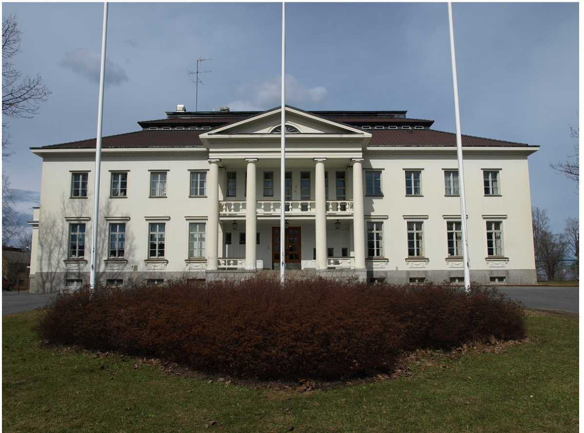
Kuva 1. Yleiskuva varsinaisen kohteen etupihalta
