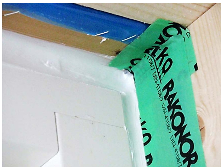
Kuva 9. Ovikarmin tiivistys elastisella massalla ja tiivistysteipillä
