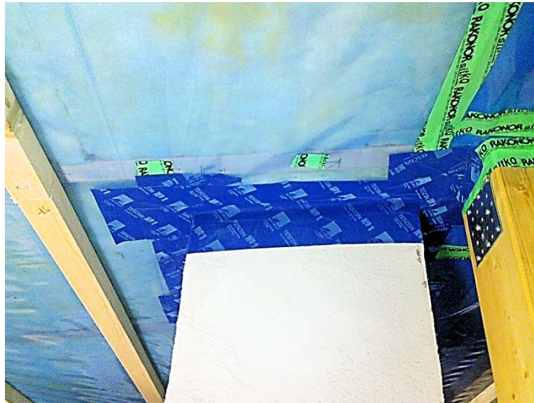
Kuva 5. Savuhormin tiivistys kangaspohjaisella tiivistysteipillä
