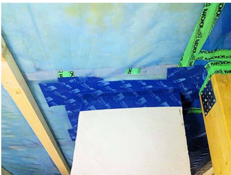
Kuva 14. Savuhormin tiivistys Tescon N:o 1 teipillä ja pilarin tiivistys Rakonor sitko-teipillä yläpohjaan.
