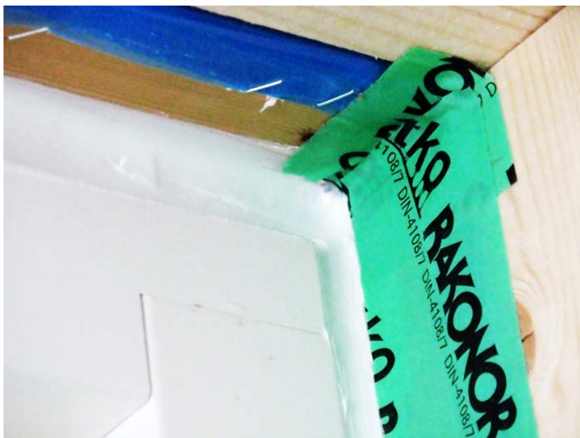
Kuva 7. Ovikarmin tiivistys elastisella massalla ja tiivistysteipillä
