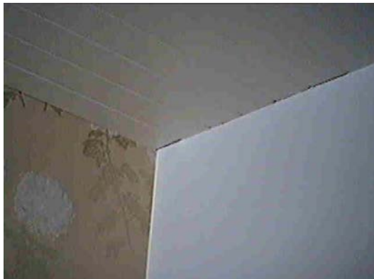
Kuva 16. Lämpökuvauksella todennettu ilmanvuotokohta kantavan väliseinäpalkin kohdalla ulkoseinärakenteessa
