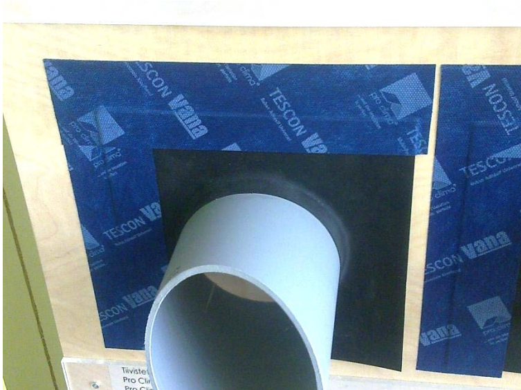
Kuva 12. Viemärintiputken kuminen läpivientitiiviste varmistettuna tiiveysteipillä
