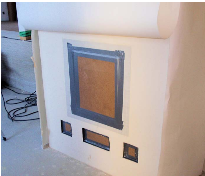
Kuva 19. Tulisijan luukkujen tiivistys teippaamalla
