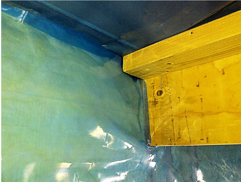
Kuva 17. Kantavan väliseinän liittyminen ulkoseinärakenteeseen ennen tiivistystä
