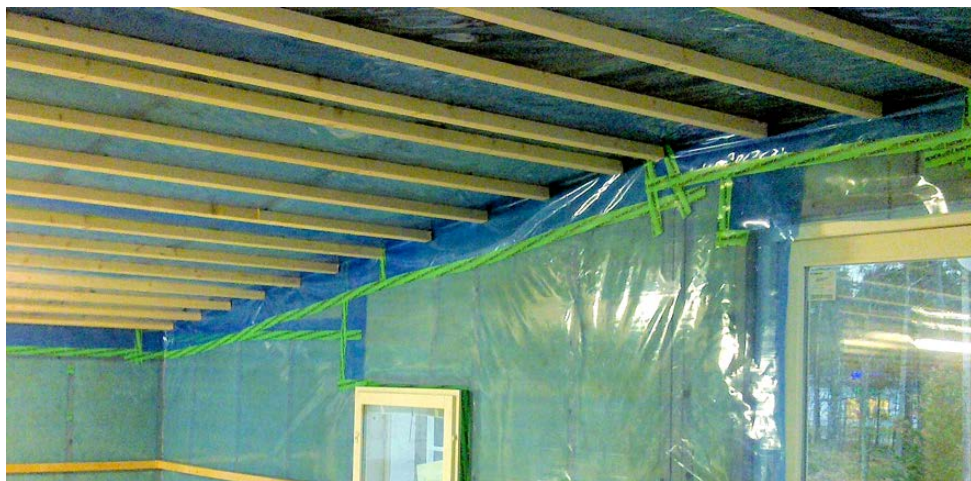
Kuva 16. Höyrynsulun tiivistys teippaamalla
