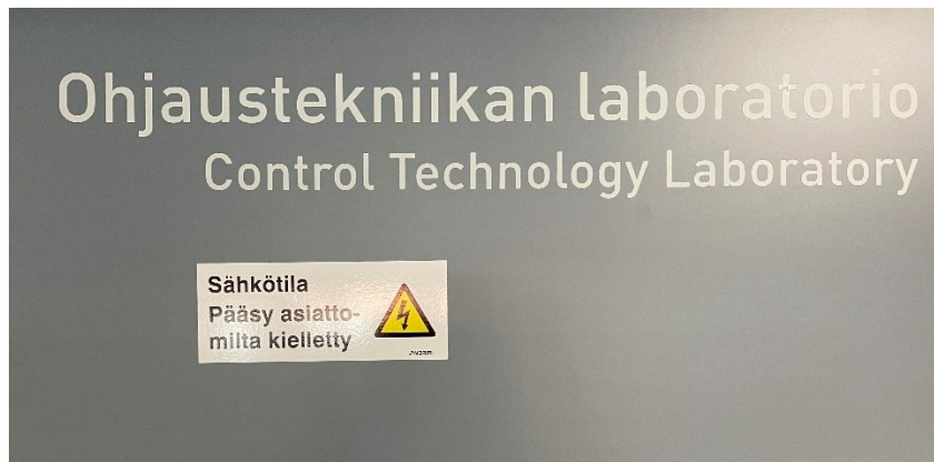
Kuva 7. Laboratorion ovessa oleva tarra, joka ilmoittaa sähkötilasta.
