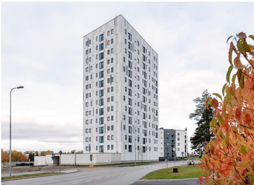
Picture 3 Lighthouse in Joensuu. Source: https://ereijonen.fi/oma-asuntotuotanto
