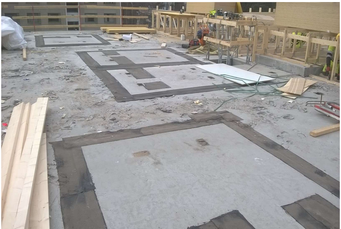
Kuva 9. Asennuksen jälkeen huovat heti paikoilleen ennen työvuoron loppua. (lähde: Farhad Kheirkhah)
