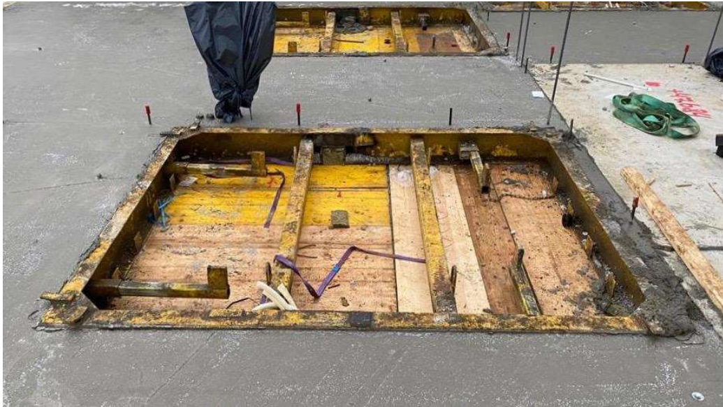
Kuva 5. Teräsmuotti holvin sisällä (lähde: Farhad Kheirkhah)
