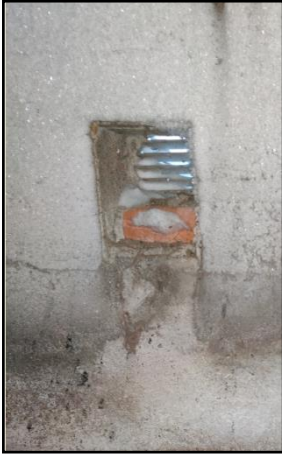
Kuva 8. Pienennetty tuuletusaukko
