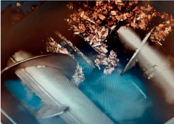
Kuva 10. Sulkusyöttimen valvontakameran kuvaa, jossa sulkusyötin syöttöruuvien alapuolella, mutta ei näy savun muodostuksen vuoksi.
