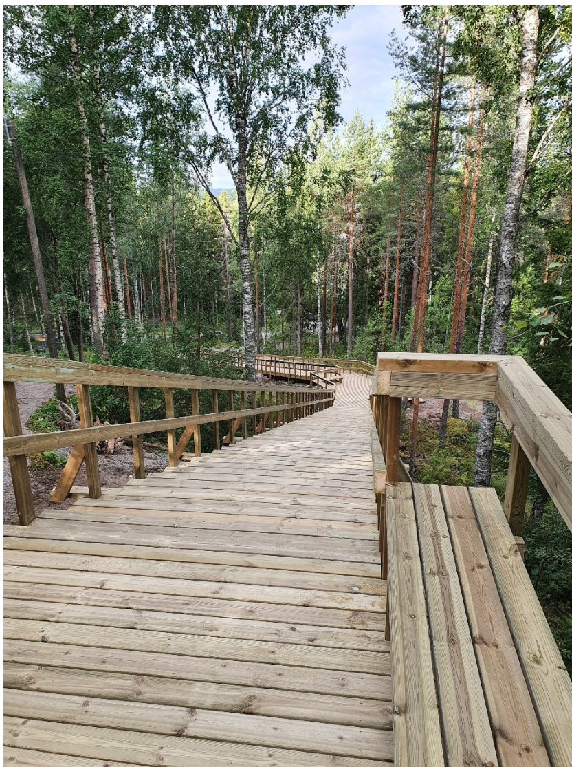
KUVA 16. Kuntoportaat maastossa. Kuvassa näkyy jyrkemmän osuuden loppuosan lepotasanne
