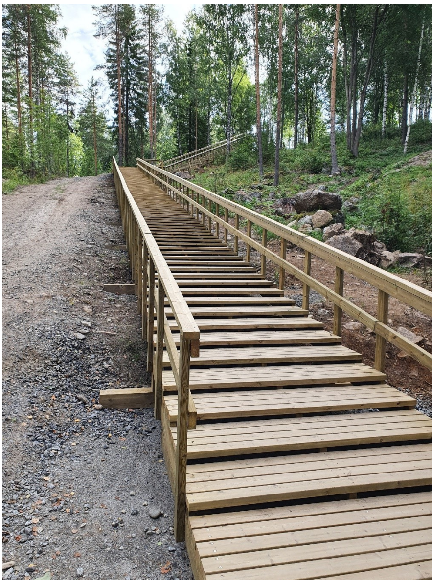
KUVA 15. Kuntoportaat maastossa. Kuvassa näkyy loivempi osuus 100 mm:n askelkorkeudella
