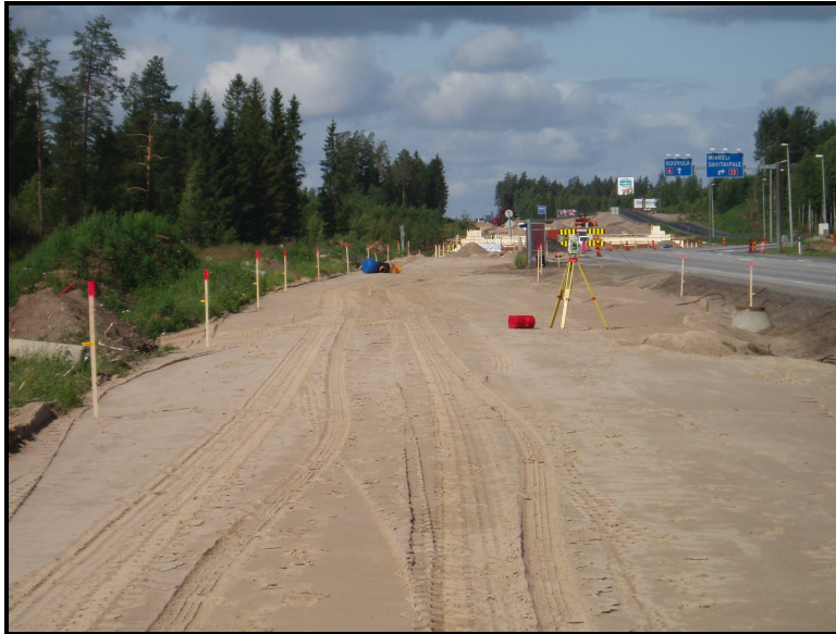
Kuva 2. Tielinjan merkintää mittarima/korkolappumenetelmällä, mittalaitteena robottitakymetri.
