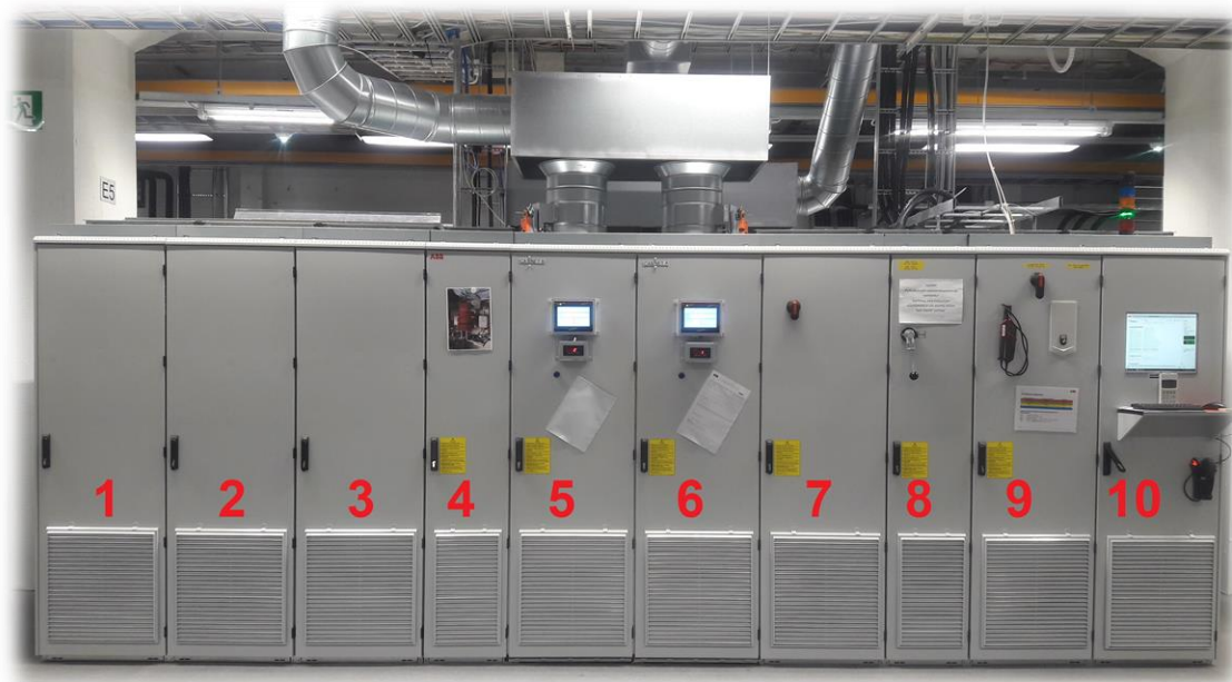
Kuva 14. Valmis Blue-DS-koestuslinja toiminnassa. Kaapeissa 1-3 sijaitsevat kuormakuristimet. Kaapit 5 ja 6 ovat moduuleiden koestuskammiot. Kaapissa 7 sijaitsee tasasuuntaajayksikkö. Kaapissa 8 sijaitsee pääkatkaisija. Kaapeissa 4 ja 9 sijaitsevat apulaitteistot ja kaapissa 10 on koestajan käyttöliittymä.
