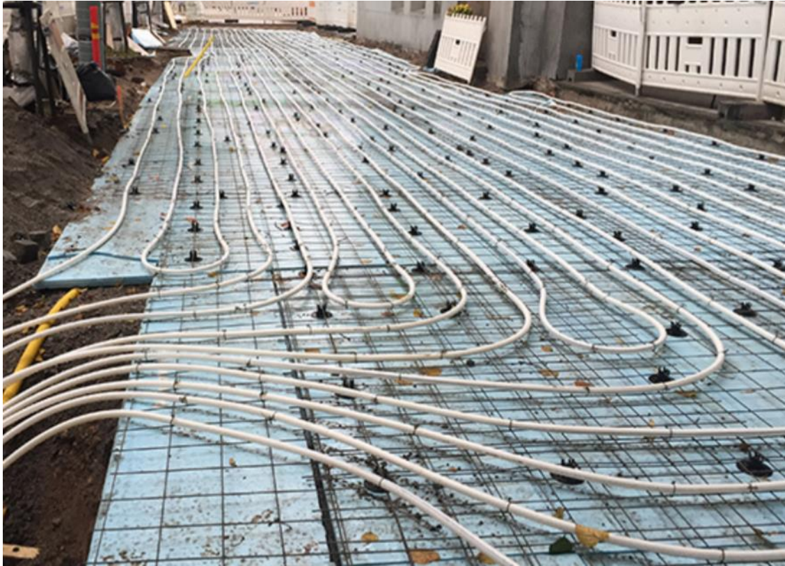
Figur 12. Installation av värmeslingor [1]
