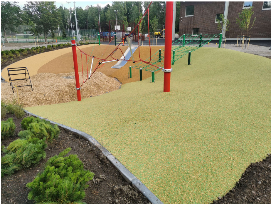
Kuva 16. Leikkivälineille tehty monttu.
