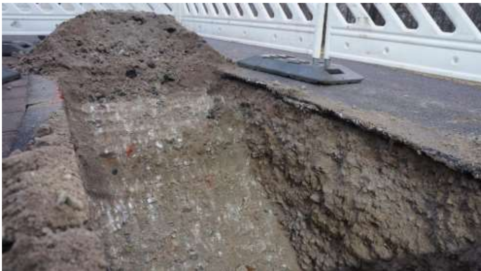
Kuva 3. Auki kaivettu betonimurske kaivanto [8.]
