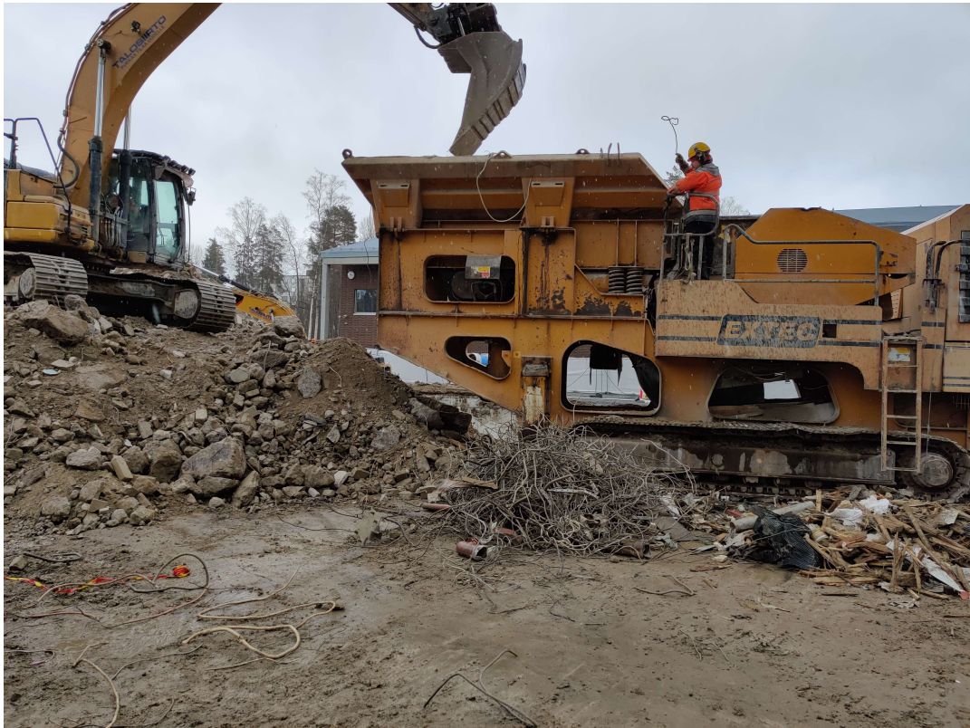
Kuva 12. Kaivinkone täyttää murskainta betonilla ja käsimes erottelee raudotteita pois.
