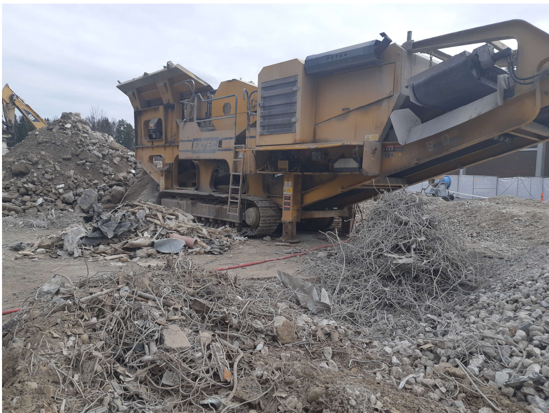
Kuva 13. Työmaalla käytössä ollut murskain.
