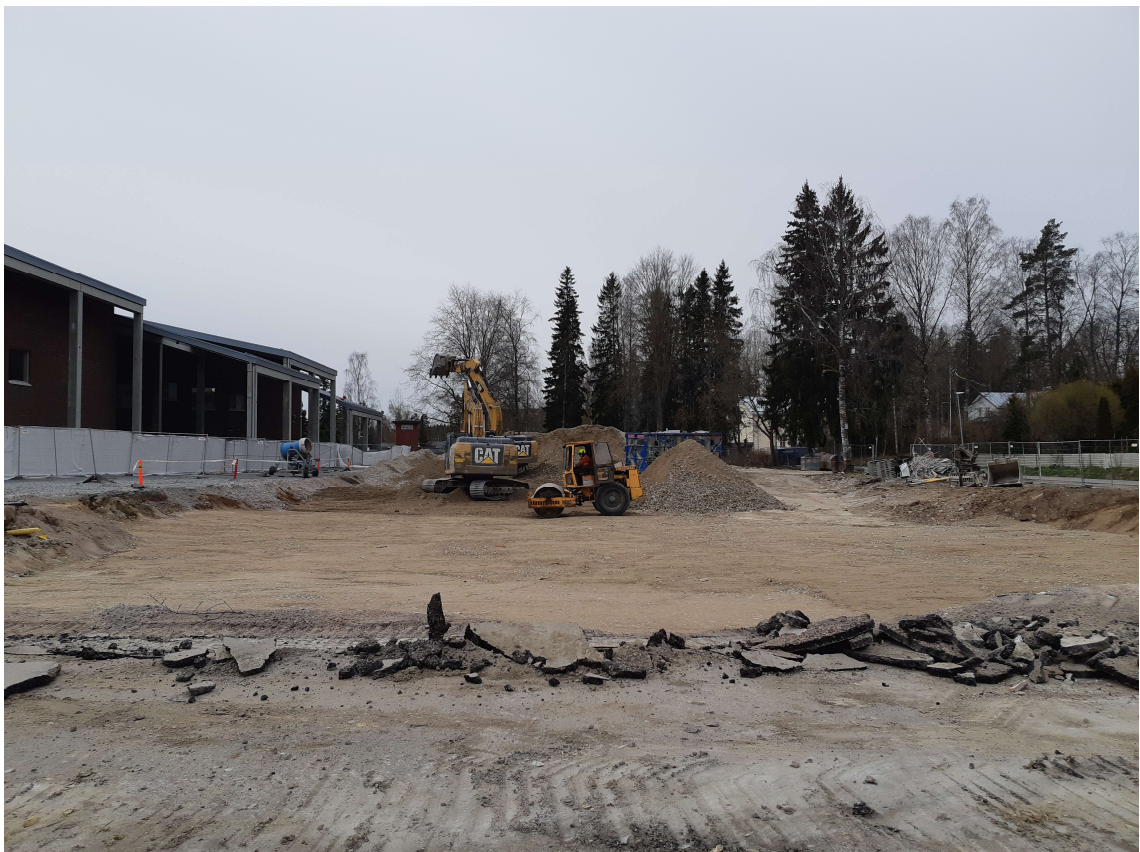
Kuva 14. Betonimurskeen tiivistykseen käytetty valssijyrä
