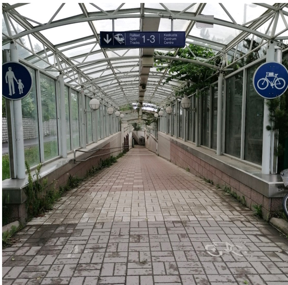
Kuva 13. Aulangon suunnasta asematunneliin kulkeva esteellinen luiska
