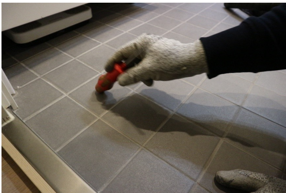
Kuva 2. Korjaustyöntekijä varmistaa irtonaisten laattojen sijainnin koputtelemalla (Tekijän kuva 18.2.2020)
