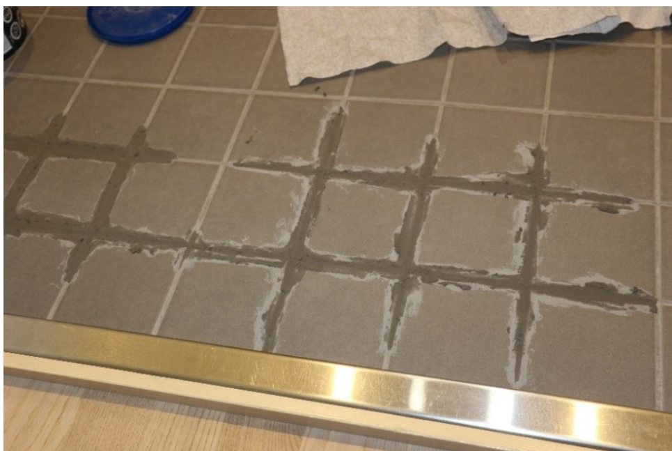
Kuva 6. Saumauksen uusiminen saumalaastilla (Tekijän kuva 18.2.2020)
