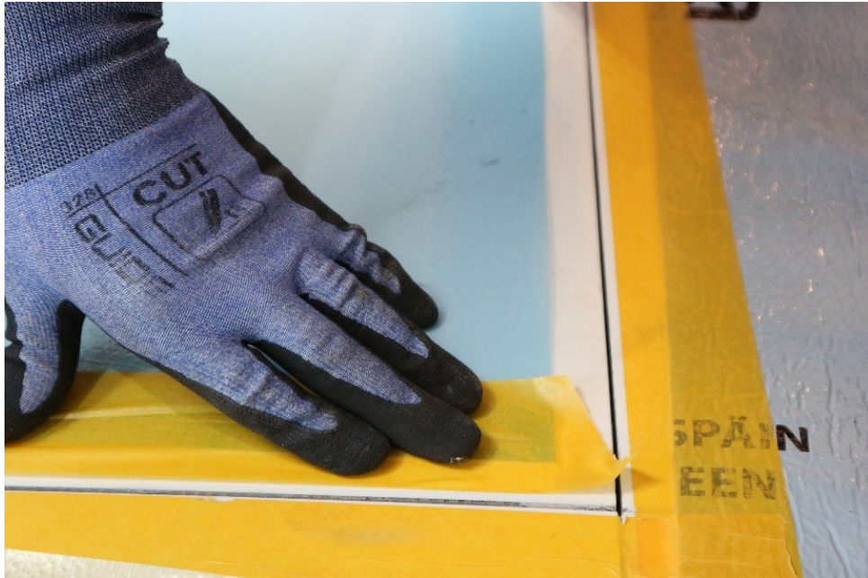
Kuva 8. Laatta muovitetaan estämään palasten lentoa (Tekijän kuva 25.2.2020)
