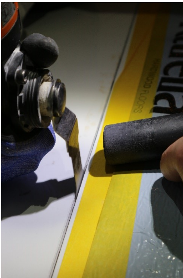
Kuva 7. Laattasauman avaus monitoimityökalulla (Tekijän kuva 25.2.2020)
