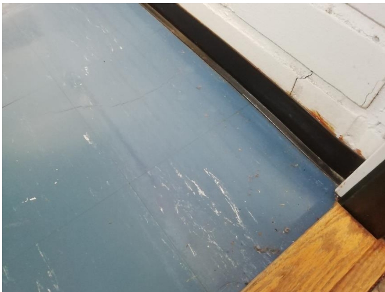
Kuva 20. Tila 11 linoleumilattia ja lattialista.
