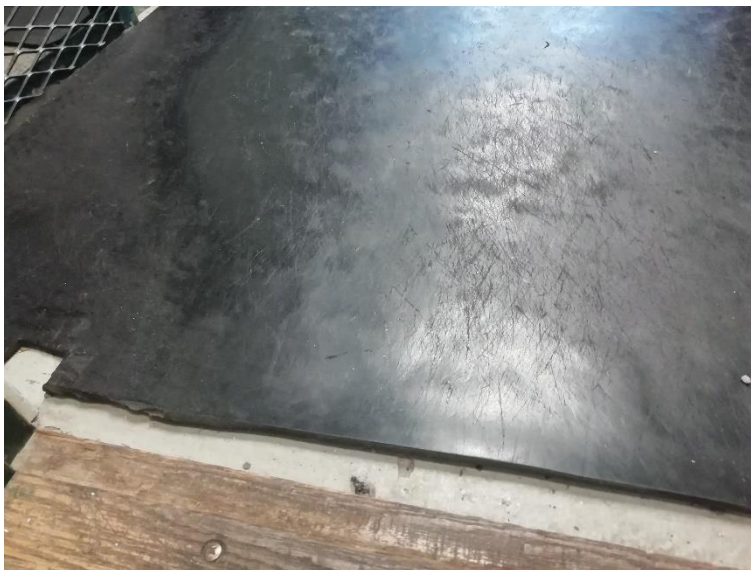
Kuva 19. Tilan 8 betonilattia ja päälle asetettu kumimatto.
