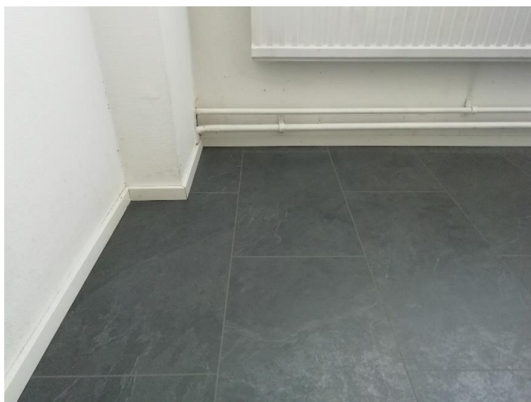
Kuva 22. Tilan 2 lattiapinta ja jalkalistat.
