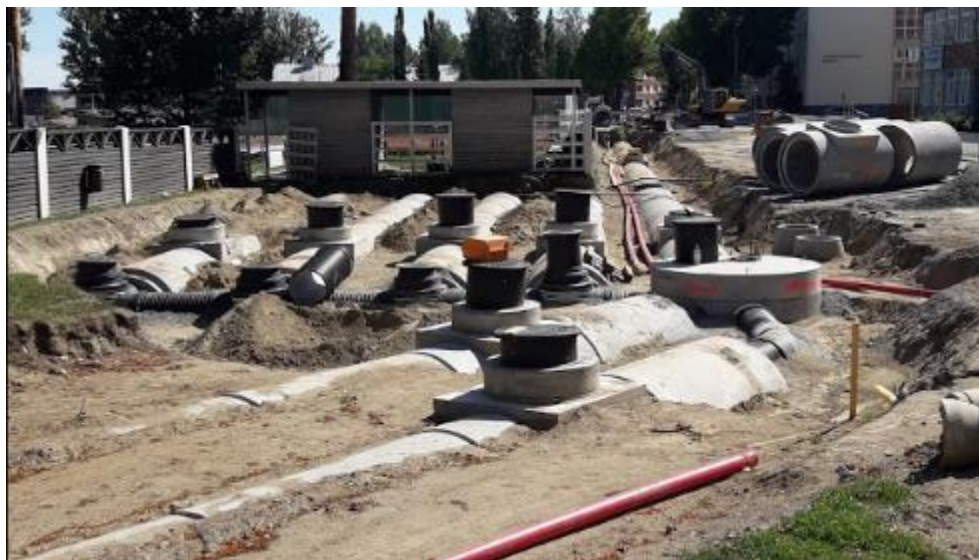
Kuva 4. Huleveden viivytyssäiliöiden rakentaminen Anni Swaninkadulla 2018
