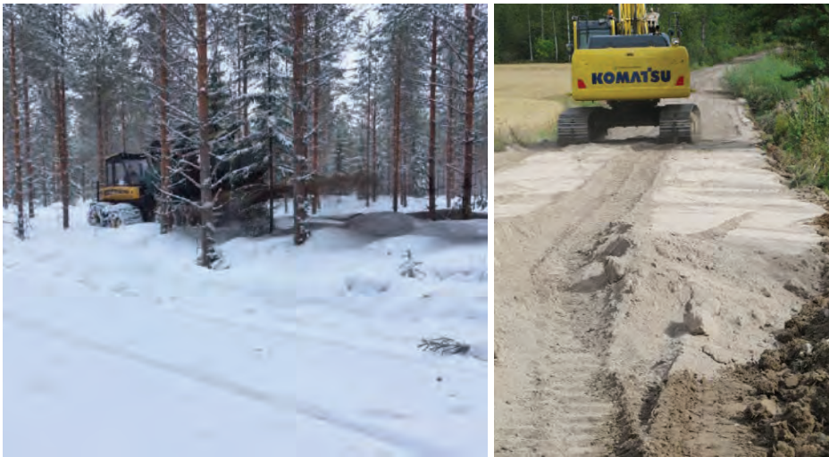
KUVA 1. Metsänlannoitusta ja tienrakentamista tuhalla (kuvat Kati Kontinen ja Samuli Joensuu).
