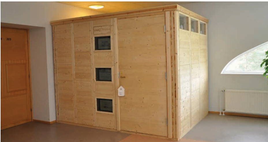
KUVA 4. CLT-paloista valmistettu Silent Room Kaakkois-Suomen ammattikorkeakoulun Kouvolan kampuksella (kuva Ville Rätty).
