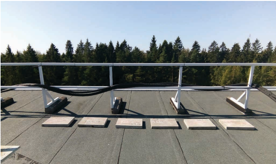
KUVA 3. Kotkan kampuksen katolla on säätestauksessa kuusi betonilaattaa, jotka sisältävät biolentotuhkaa (kuva Eveliina Kuokkanen).
