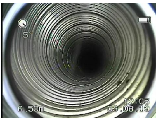
KUVA 5. Tuloilmakanavan puhtaus tarkastushetkellä
