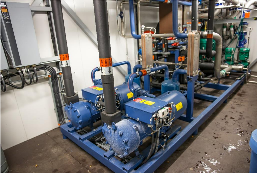
KUVA 4. Kompressorit Bitzer CSH 7573-90Y-40P, kaksi kappaletta
