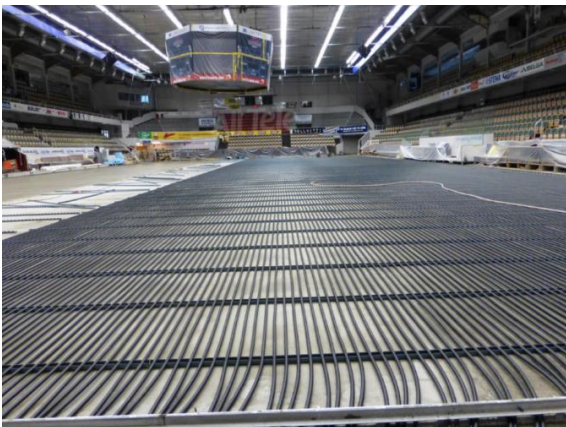
KUVA 10. Jäärataputkistoa asennettuna jäähalliin (Mukaiillen LK Systems 2018, 2.)
