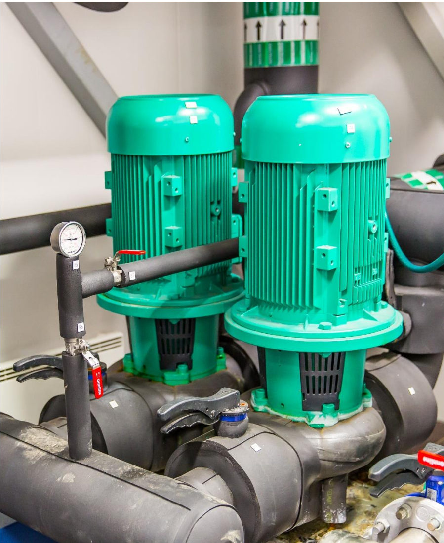
KUVA 11. Kylmäliuospumppu Wilo IL 100/150-15/2 jääntekokontissa
