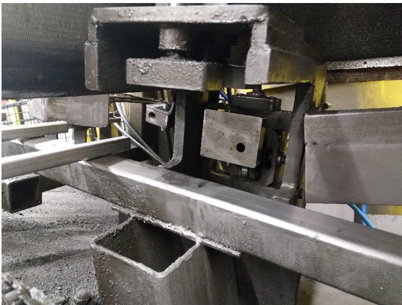
Kuva 8. HF-linjan puhallustykin tukilevy paikallaan.
