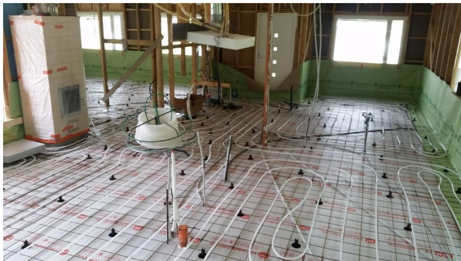
Kuva 12. Lattialämmitysputket asennettuna ja ilmasulkupaperin alahelma taitettuna (Jukka Eilers)
