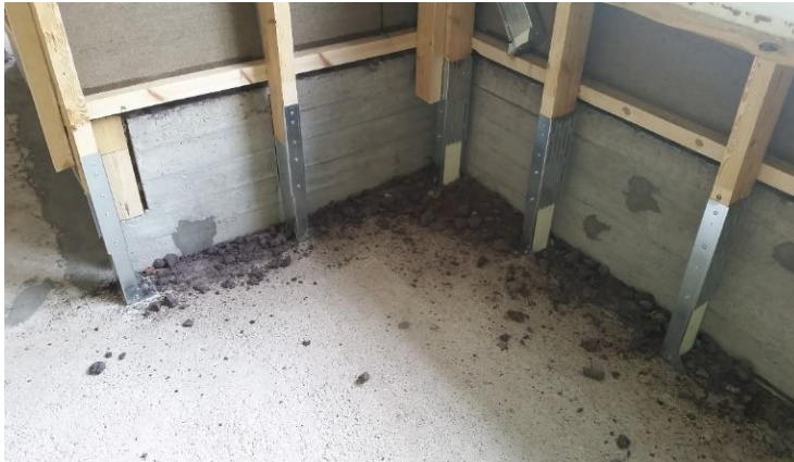
Kuva 14. Vanhaa kuivunutta laastia poistettu ulkovuoren ilmaraosta (Jukka Eilers)
