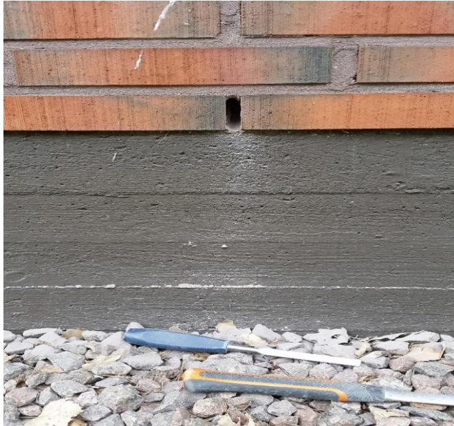
Kuva 15. Uudet tuuletusaukot ulkovuoren pystysaumoissa (Jukka Eilers)
