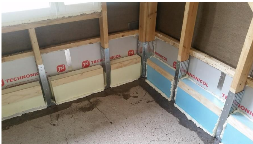
Kuva 10. Epoksoitu sokkelin ja pohjalaatan sauma. 30 mm Xps-levy sokkelin pysyosalla runkotolpan takana ja välissä 100 mm termopalkki. (Jukka Eilers)
