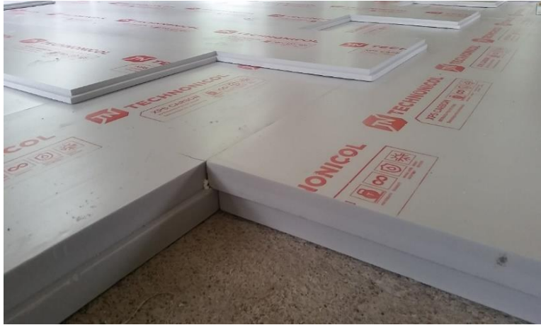
Kuva 11. Lattiaeriste xps 130 mm pohjalaatan päällä (Jukka Eilers)
