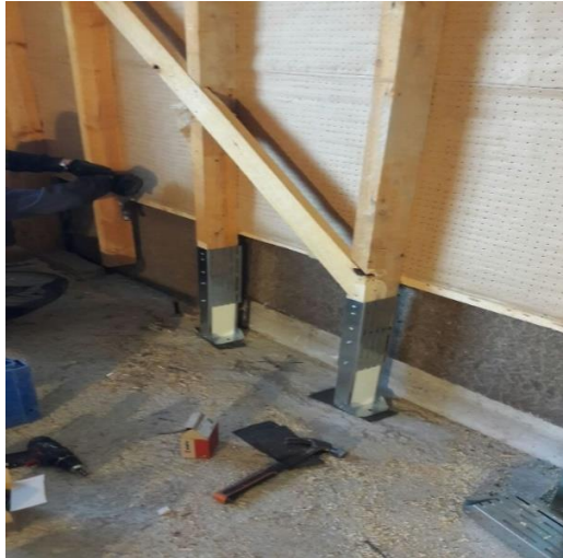
Kuva 9. Termokenkä asennettu paikoilleen (Jukka Eilers)
