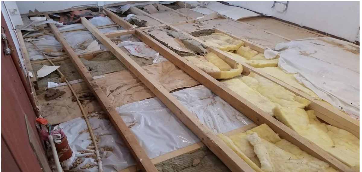
Kuva 6 Alapohjan eristetila. Sekoitus erilaisia mineraalivilloja, pahvia ja muovia. (Jukka Eilers)
